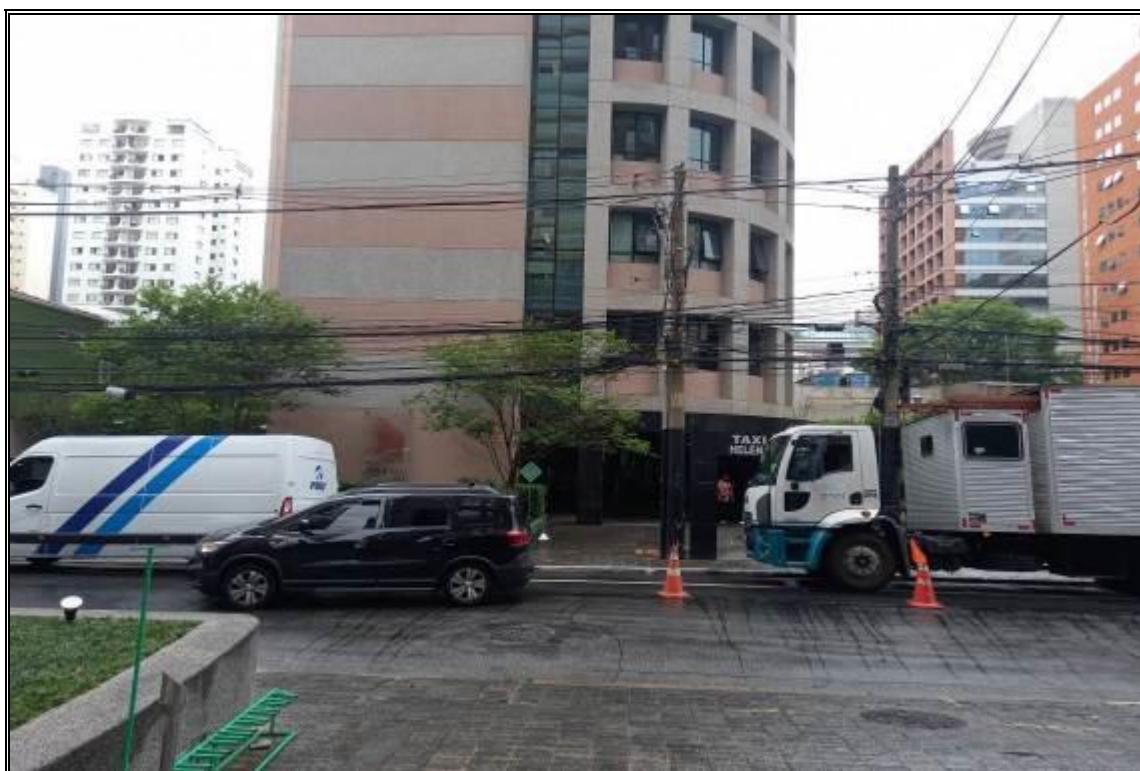
VISTA PARCIAL DA FACHADA DO EDIFÍCIO
