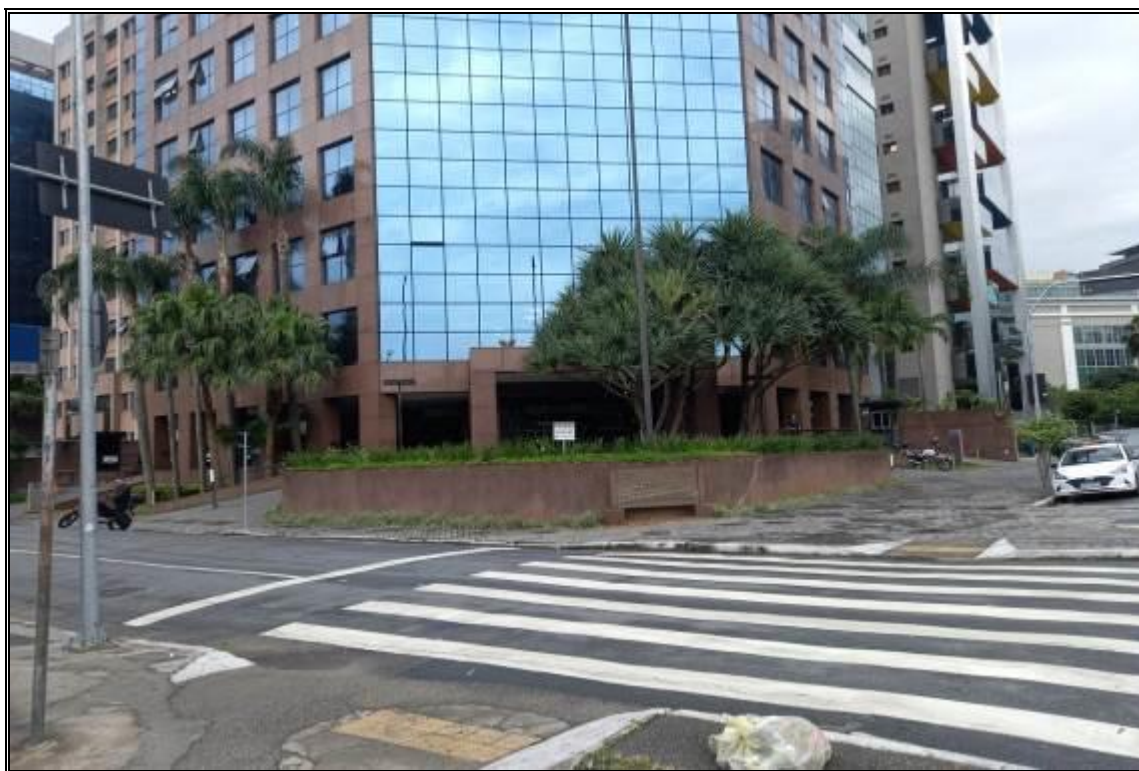
VISTA PARCIAL DA FACHADA DO EDIFÍCIO
