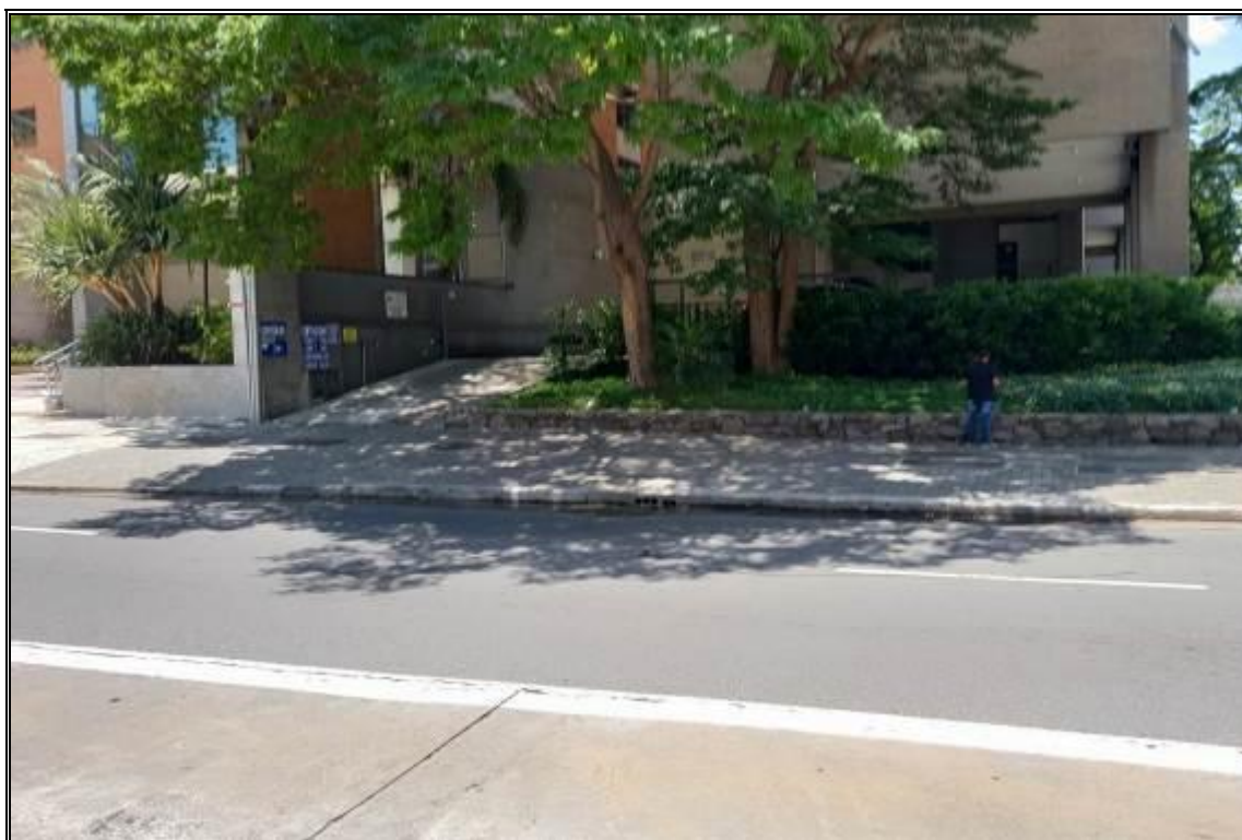
ACESSO AO EDIFÍCIO
