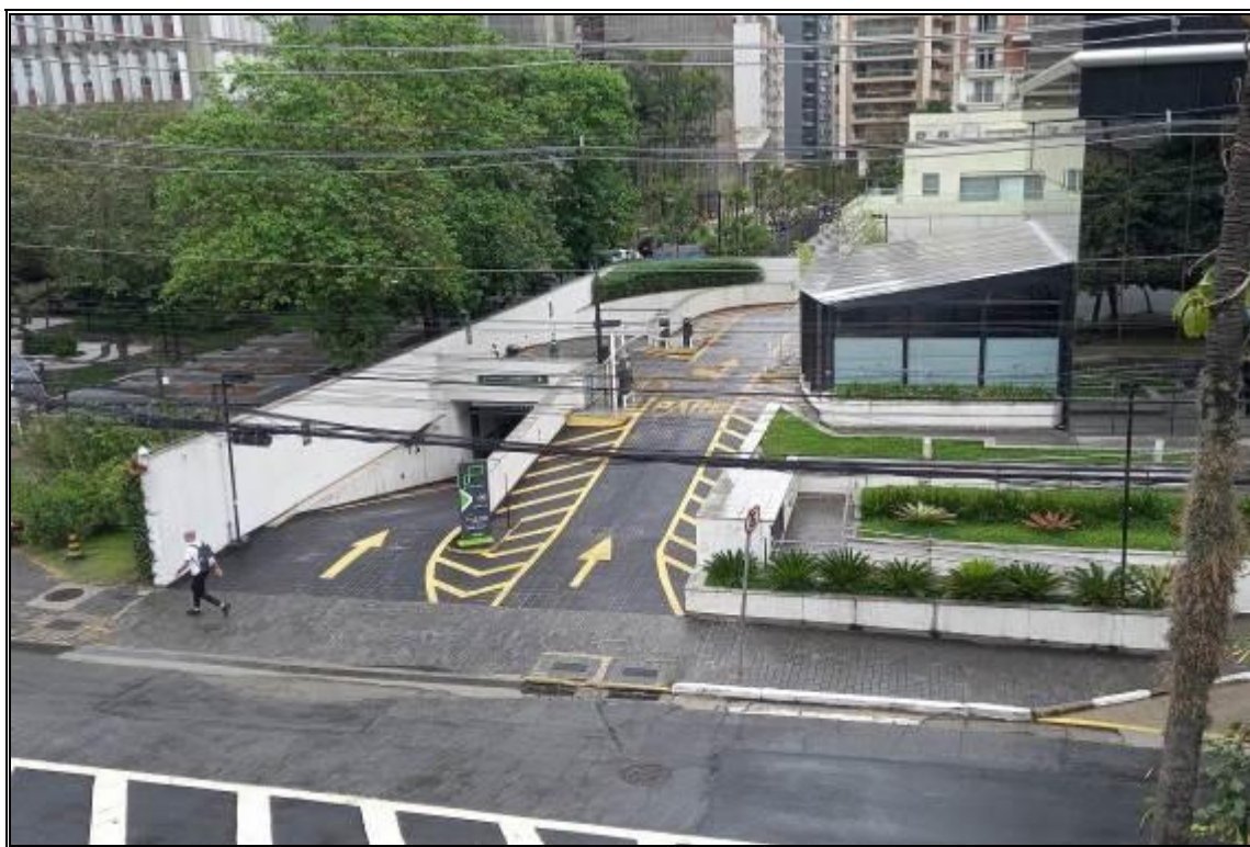
ACESSO A GARAGEM
