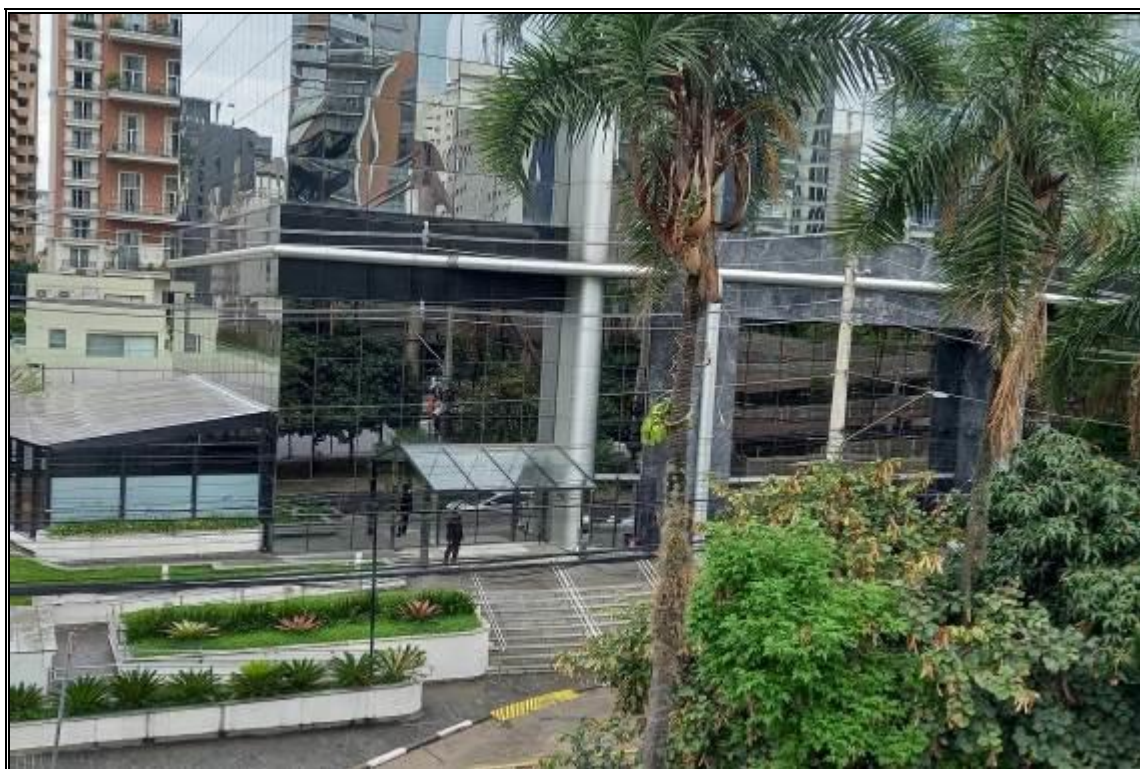
VISTA PARCIAL DA FACHADA DO EDIFÍCIO
