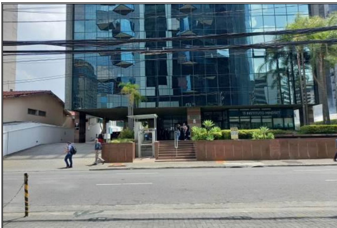
VISTA PARCIAL DA FACHADA DO EDIFÍCIO
