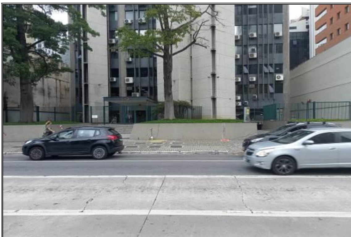
VISTA PARCIAL DA FACHADA DO EDIFÍCIO
