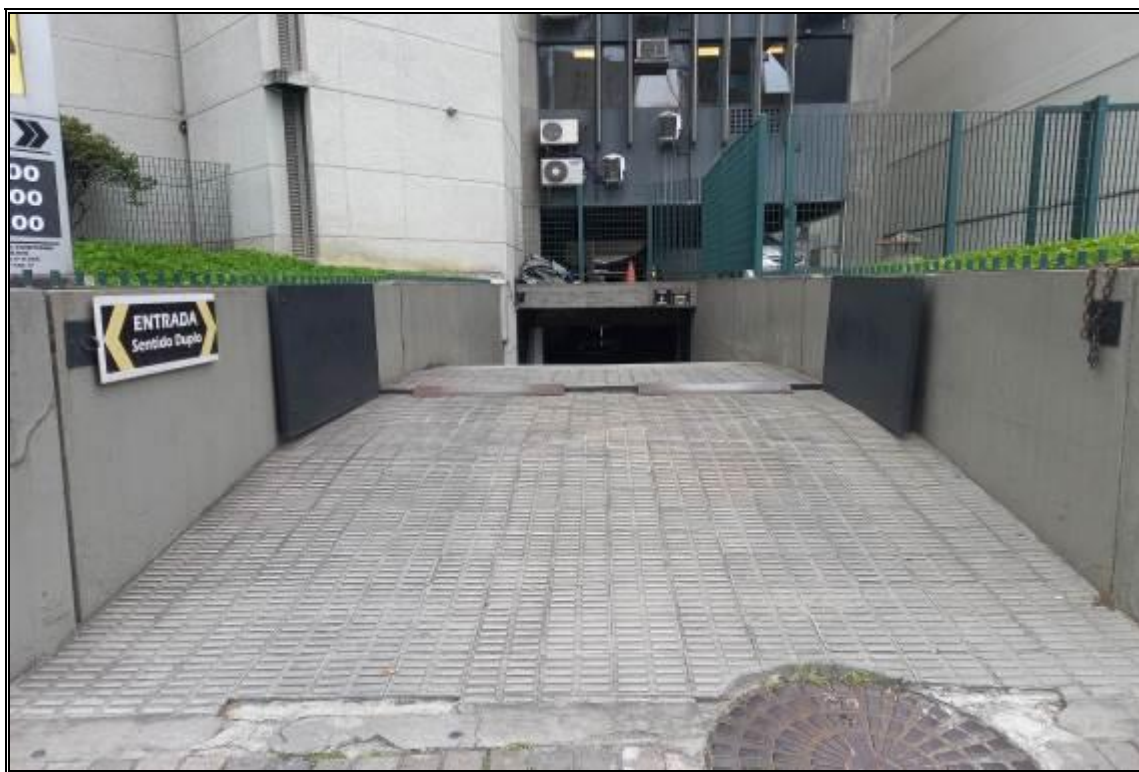
RAMPA DE ACESSO AO ESTACIONAMENTO
