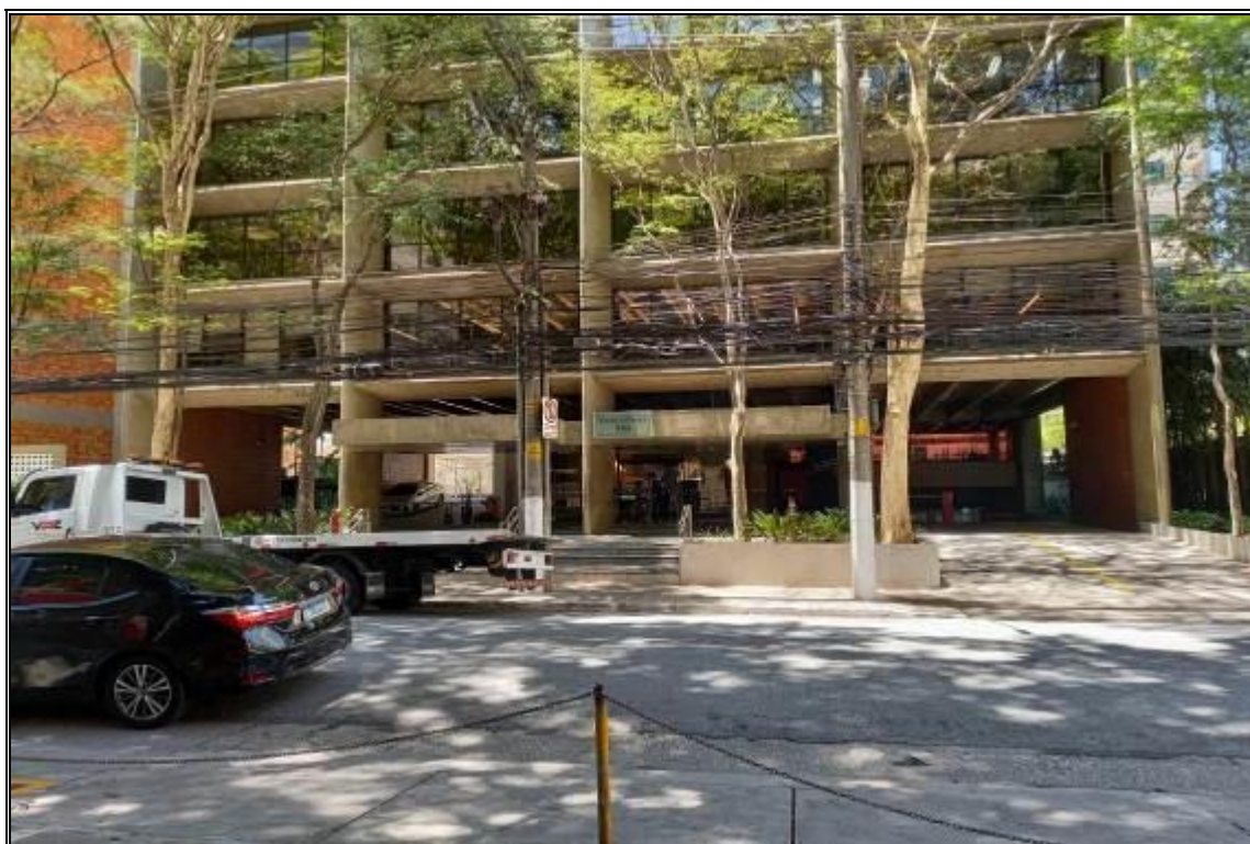
VISTA PARCIAL DA FACHADA DO EDIFÍCIO
