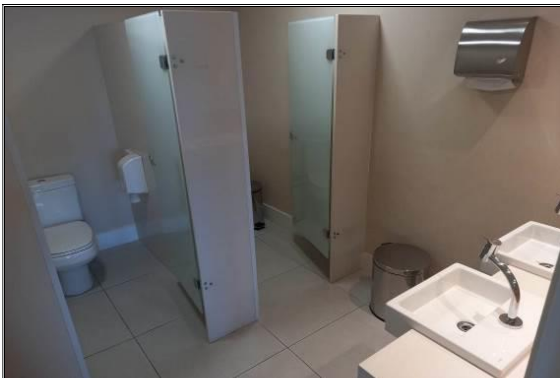
CONJUNTOS 192 A 195 – SANITÁRIO
