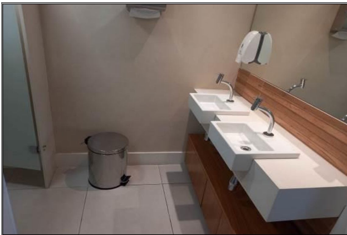
CONJUNTOS 192 A 195 – SANITÁRIO
