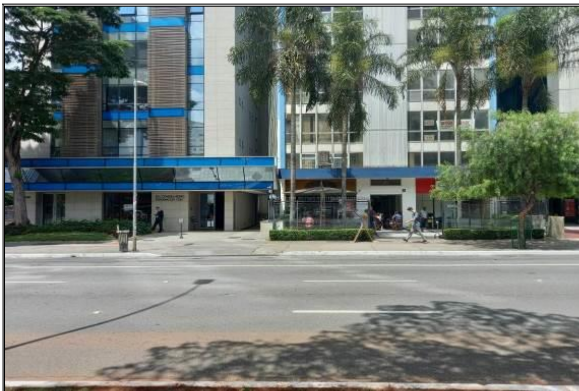
VISTA PARCIAL DA FACHADA DO EDIFÍCIO
