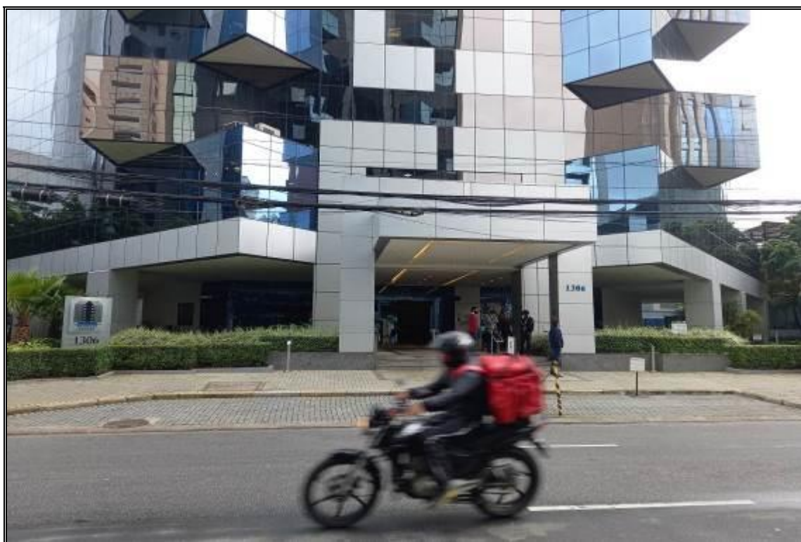
VISTA PARCIAL DA FACHADA DO EDIFÍCIO
