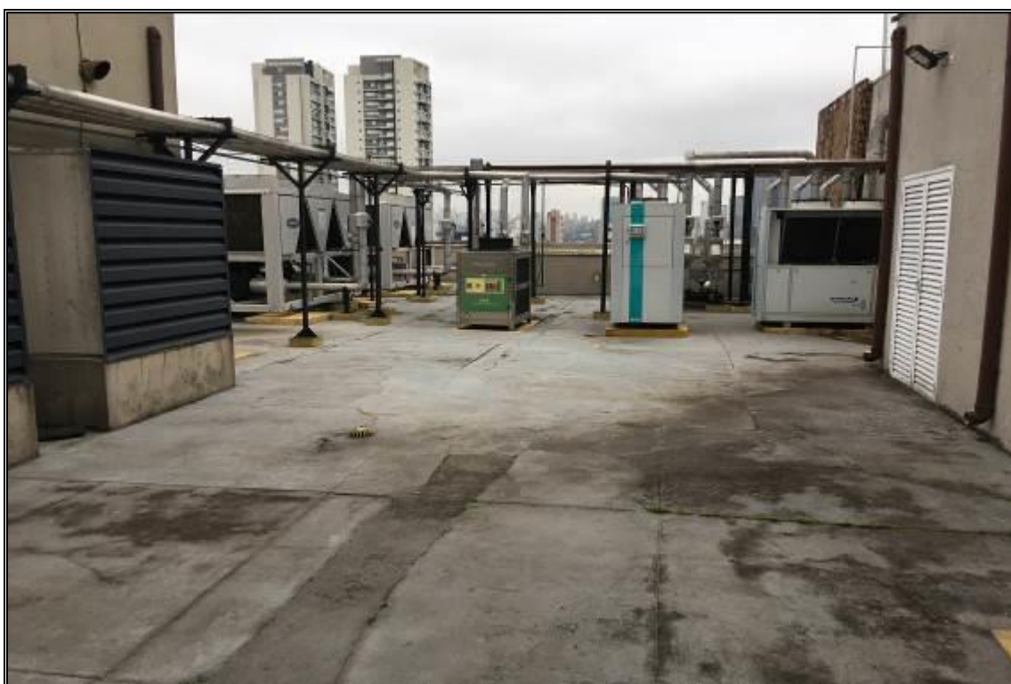
VISTA GERAL DA COBERTURA
