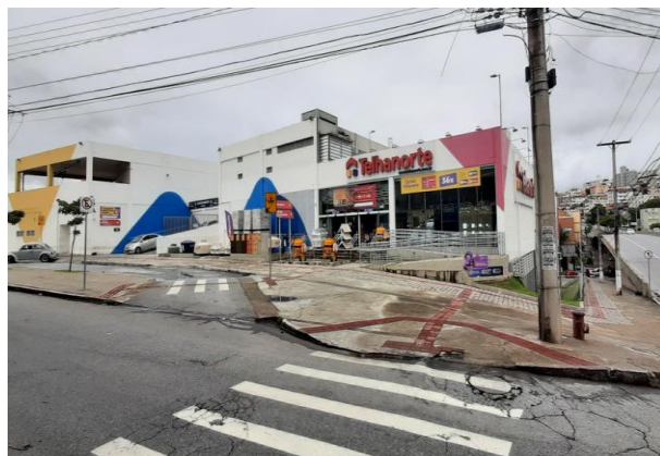
Vista Externa - Local do Imóvel Avaliando.
