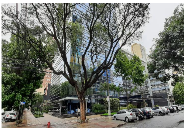
Vista Externa do Edifício Renaissance Work Center.
