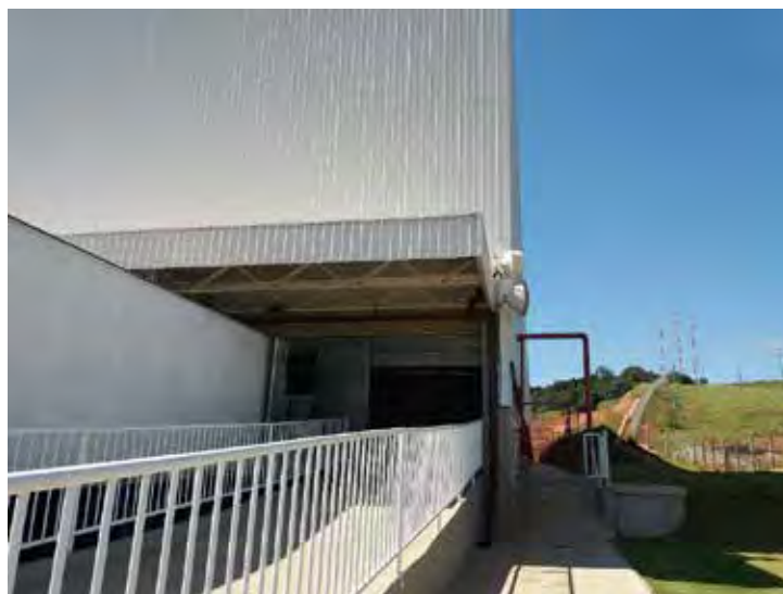
Área de marquise e galpão
