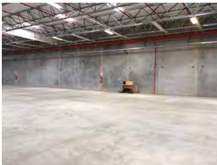
Vista interna do galpão
