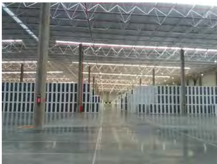
Vista interna do galpão
