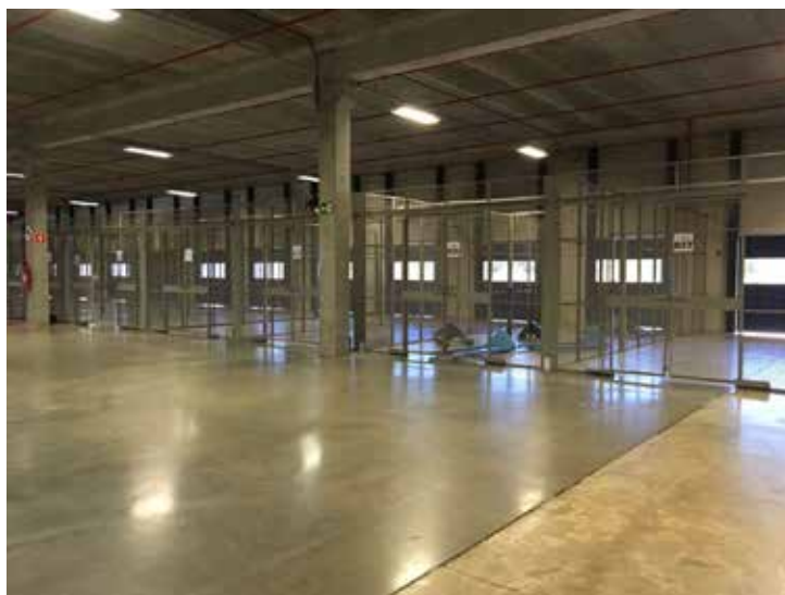
Vista interna do galpão
