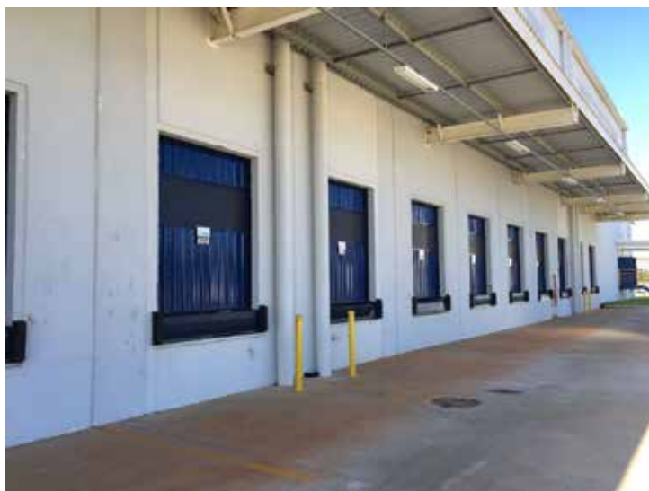
Área de marquise e docas
