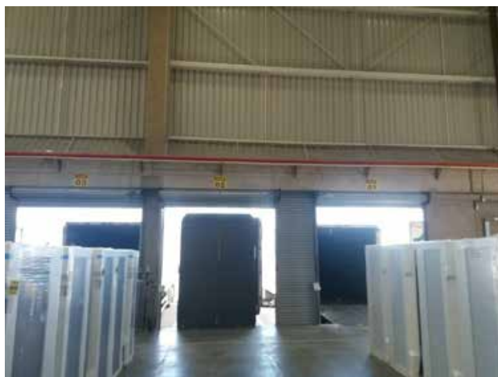
Área de marquise e galpão
