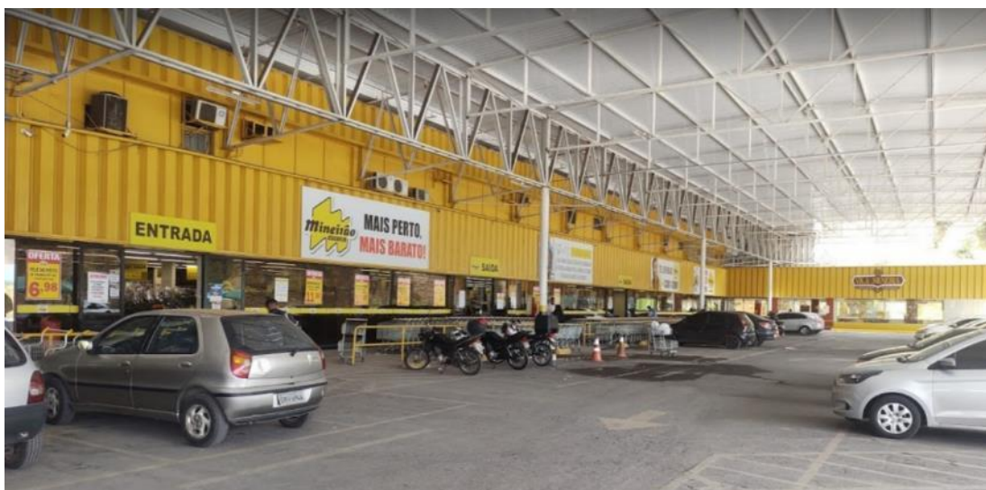
VISTA PARCIAL DO PÁTIO DE ESTACIONAMENTO E FACHADA DA LOJA
