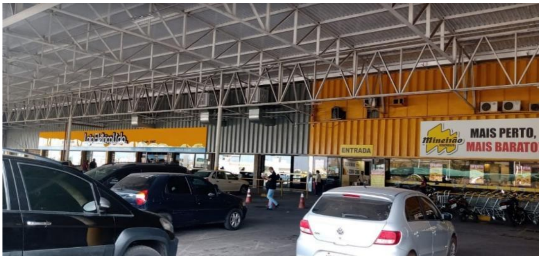
VISTA PARCIAL DO PÁTIO DE ESTACIONAMENTO E FACHADA DA LOJA
