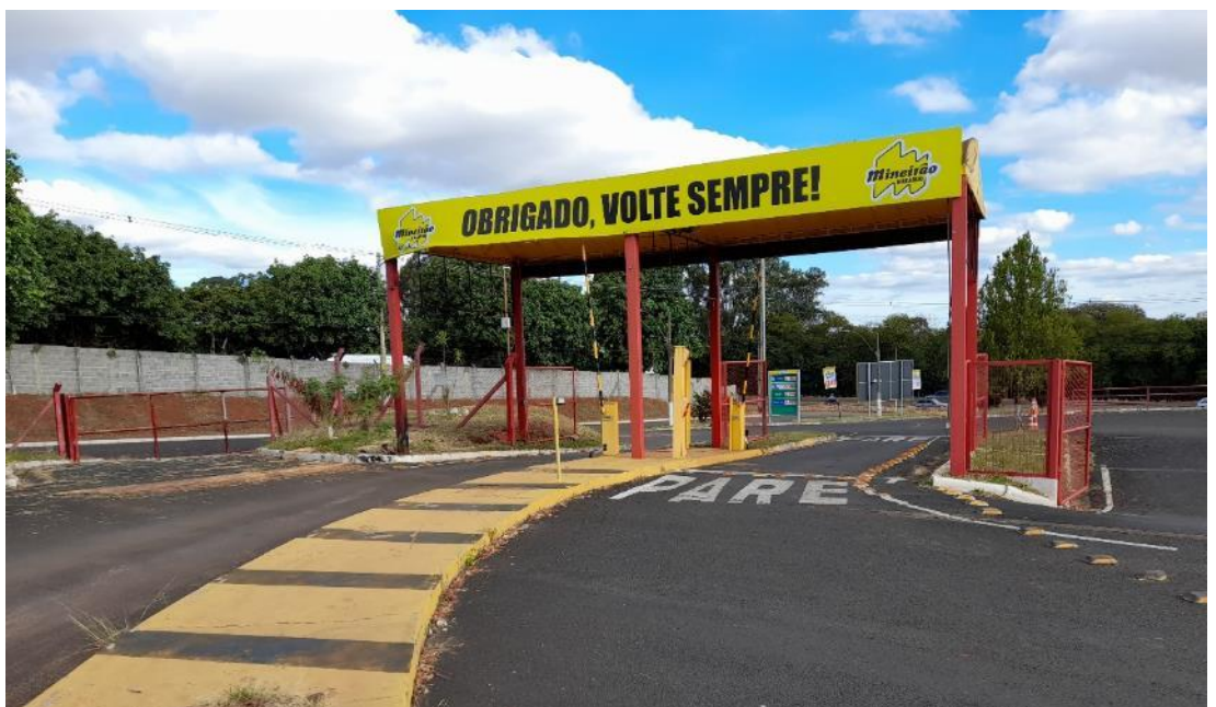
ACESSO DO IMÓVEL
