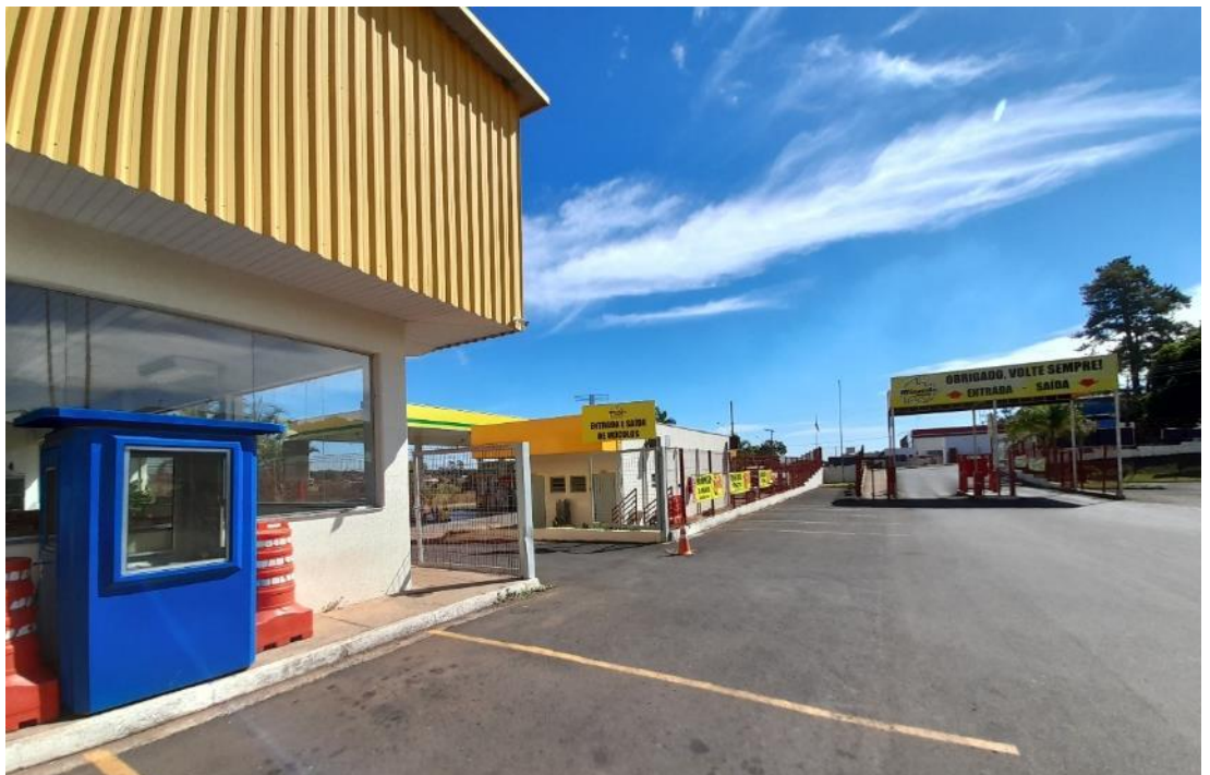
ACESSO DO IMÓVEL
