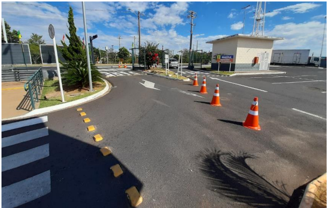
ACESSO DO IMÓVEL
