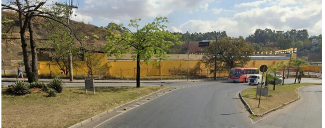
VISTA LATERAL DO IMÓVEL, A PARTIR DO VIADUTO COLUMBIA
