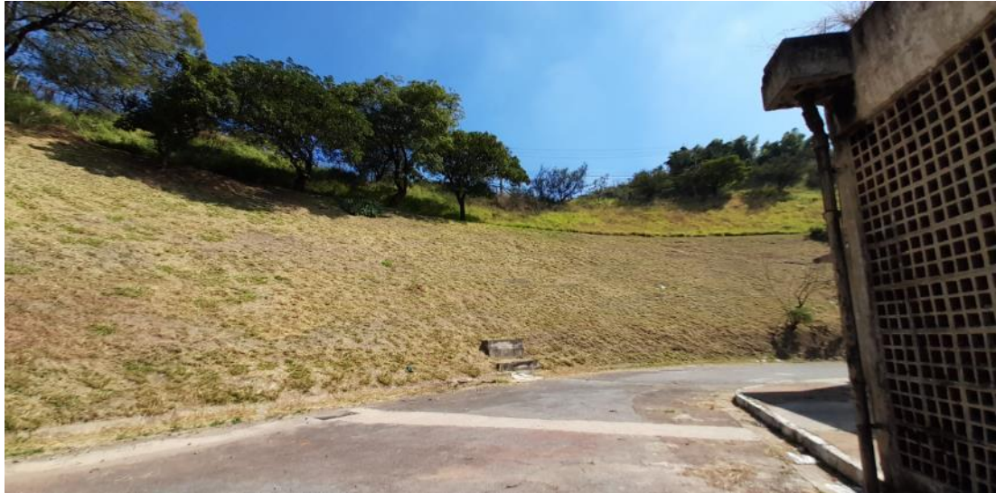
TALUDES NOS FUNDOS DO TERRENO
