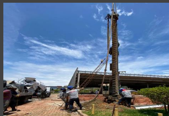
FINALIZAÇÃO DEMOLIÇÃO, REMOÇÃO ENTULHO E INÍCIO DA CONCRETAGEM DAS ESTACAS
