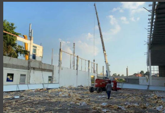
LIMPEZA E RETIRADA DA ANTIGA COBERTURA DO GALPÃO
