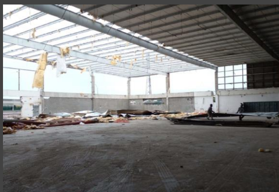
LIMPEZA E RETIRADA DA ANTIGA COBERTURA DO GALPÃO
