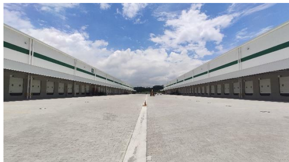
Vista do empreendimento com os dois galpões
