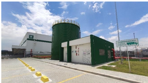
Reservatório de águas pluviais e casa de bombas
