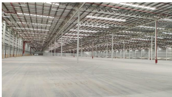
Vista interna do galpão A
