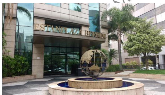
Entrada do Edifício
