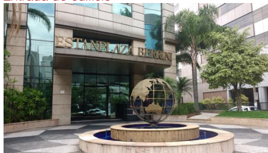
Entrada do edifício
