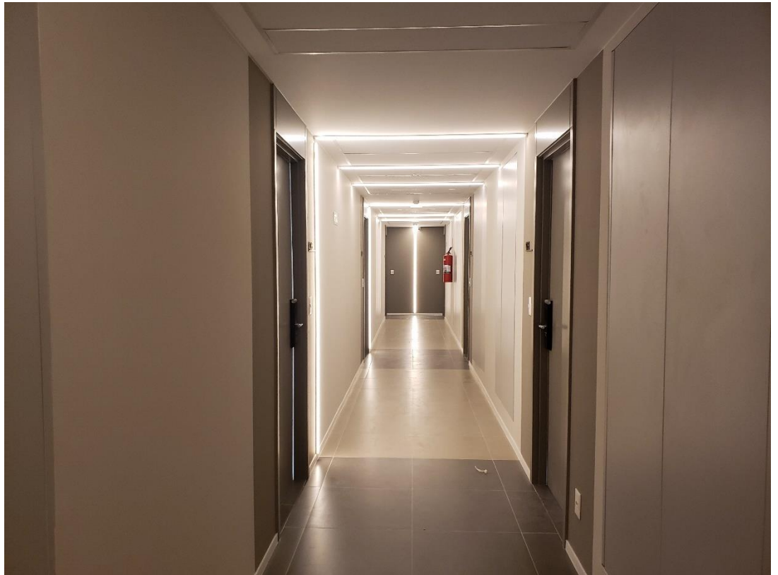
CORREDOR DE ACESSO AOS APARTAMENTOS
