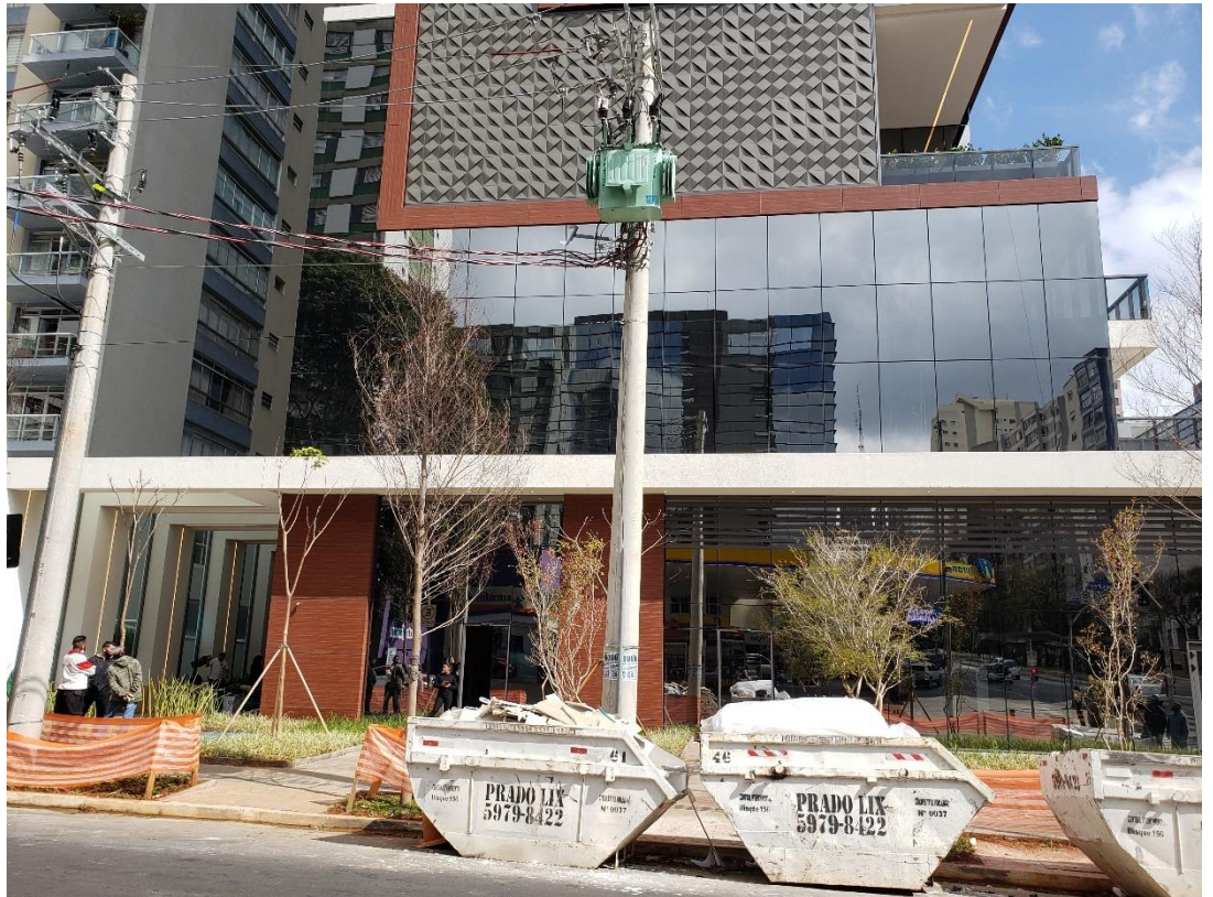
ENTRADA DOS APARTAMENTOS E SALAS COMERCIAIS
