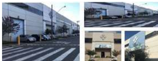
CEA Atibaia / Jarinú, SP Av. Tégula, 888, Ponte Alta Área Construída: 36.545 m 2 Participação: 100% Pé-direito (m): 8,5-8,8 Capacidade do Piso (ton/m 2 ): 5
