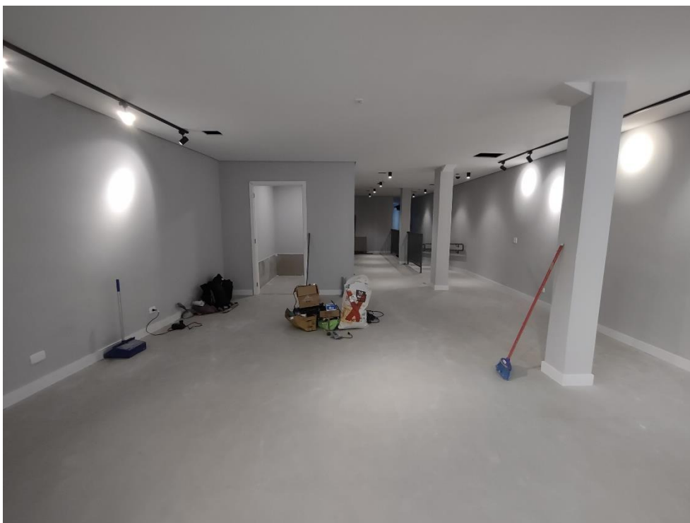
Andar térreo vista geral
