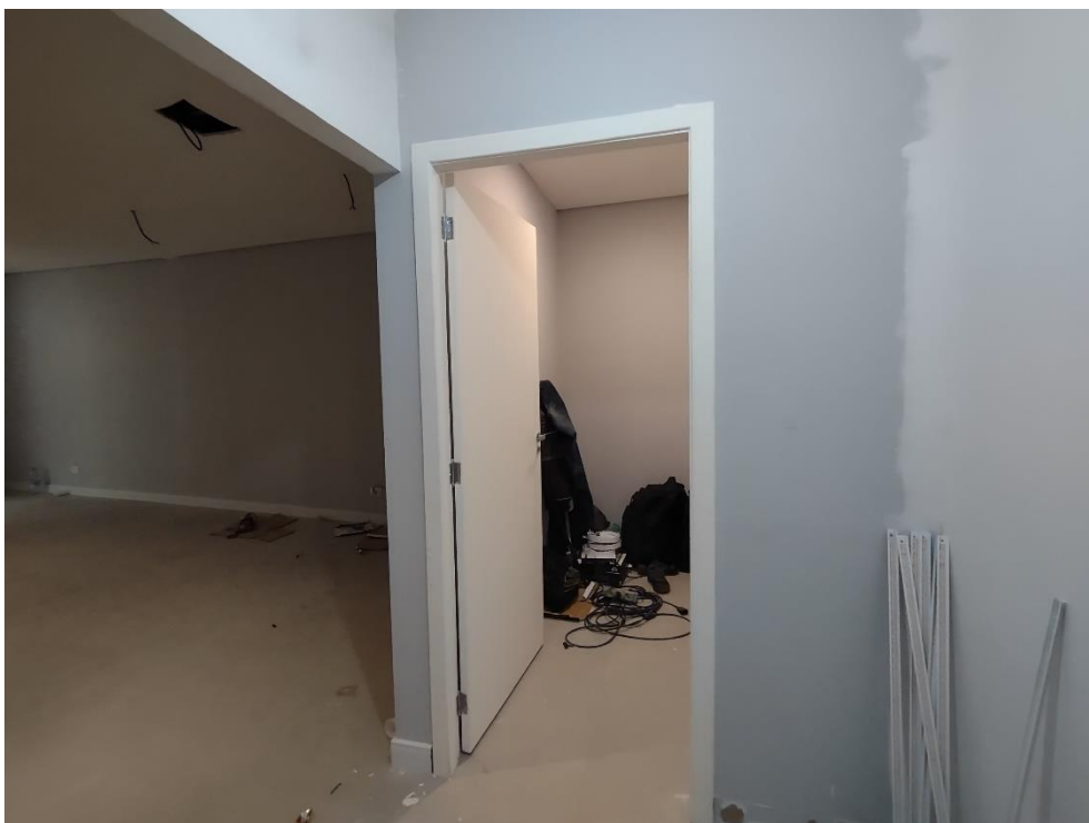
Sala 1º andar vista geral
