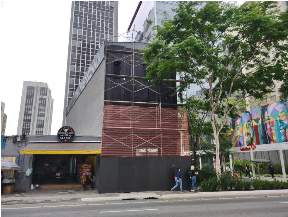
Fachada para a Rua da Consolação
