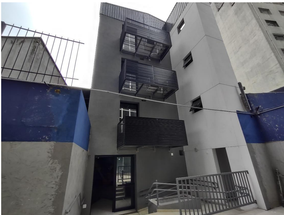
Fachada do acesso indireto pela Universidade São Judas
