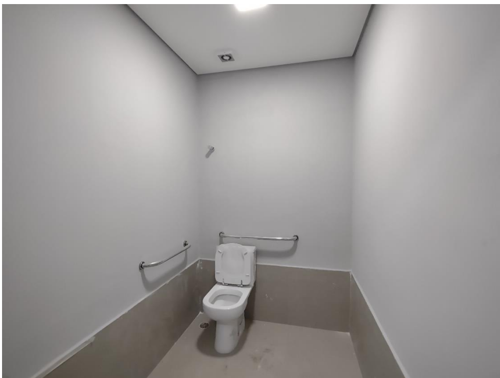
Banheiro PNE do 2º andar
