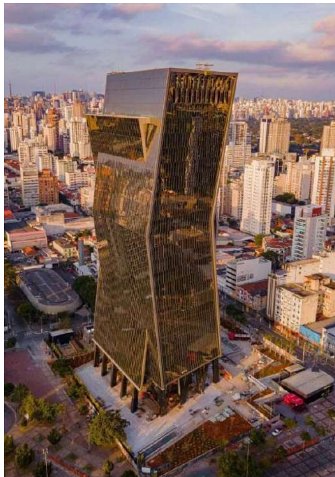
Foto da obra em andamento
