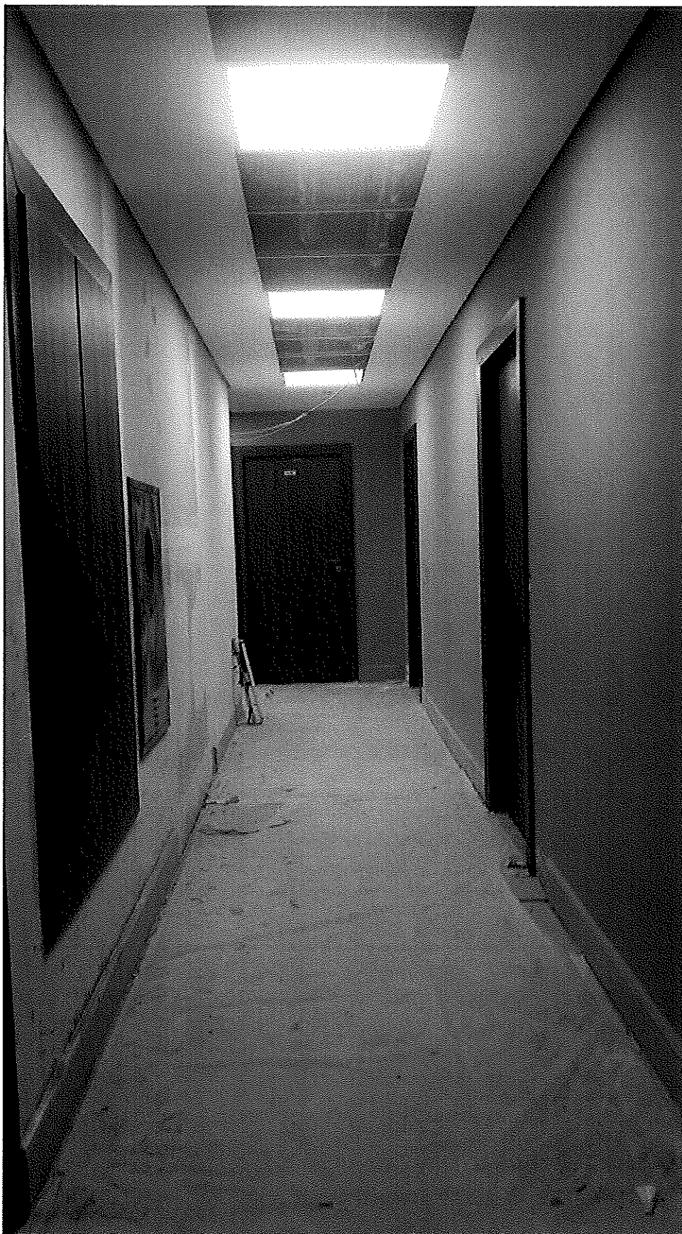
Figura 9 - Corredor do 6º pavimento com iluminação, portas e armários prontos - Global Tower
