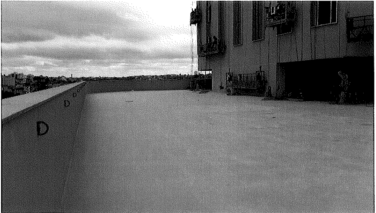
Figura 10 - Terraço descoberto do 7º pavimento – Global Tower
