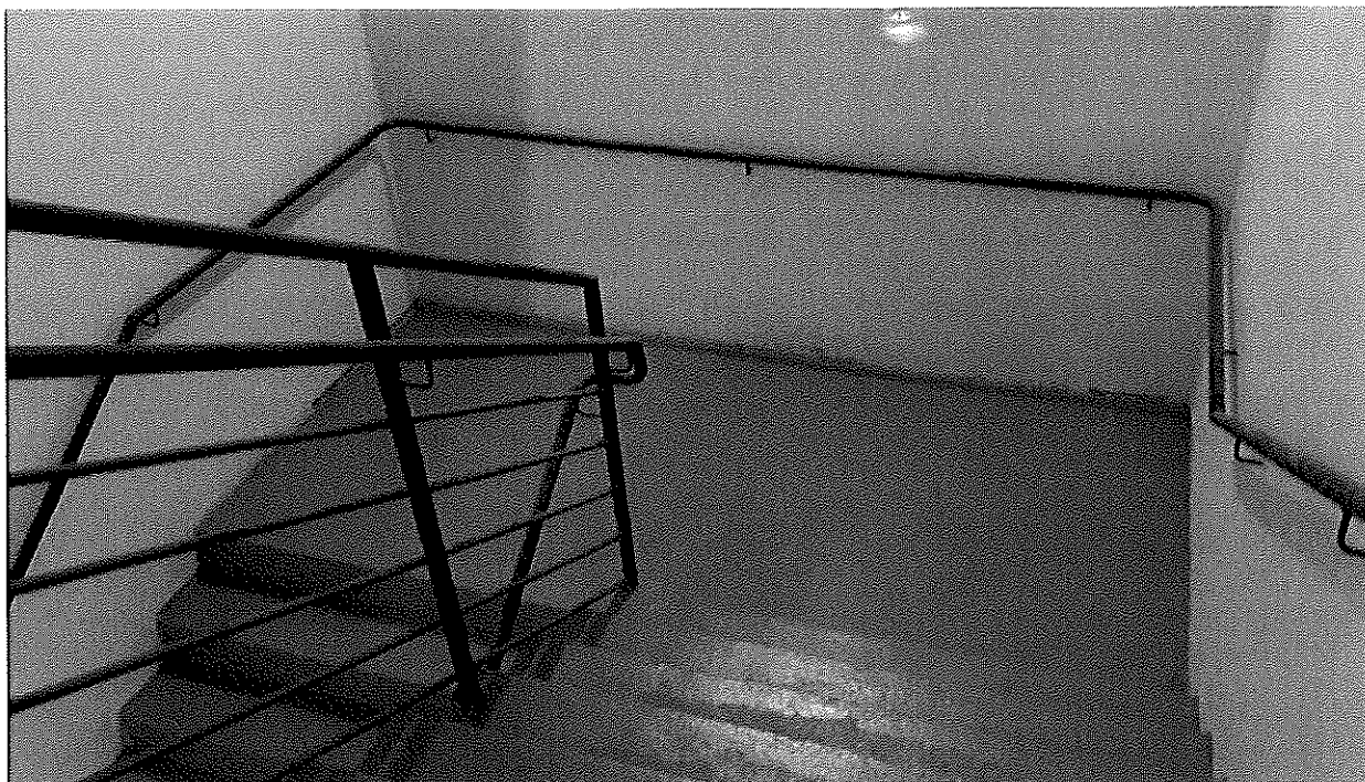
Figura 12 - Pintura do piso das escadas de Incêndio em epóxi - Global Tower
