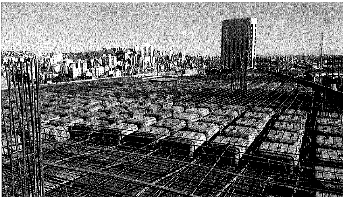
Figura 14 - Laje setor B em execução (6º pavimento) - Power Shopping
