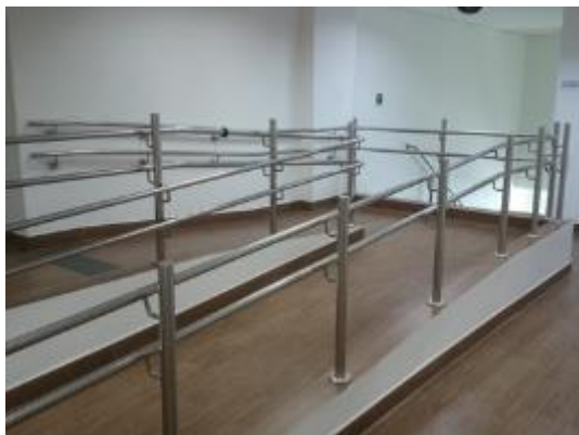
Rampa de acesso no 4º pavimento
