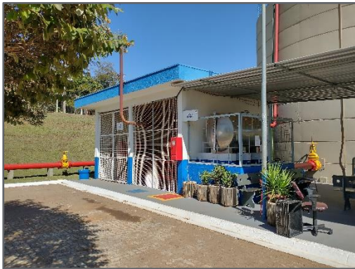
Casa de bombas
