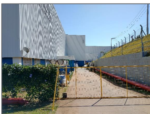
Lateral do imóvel
