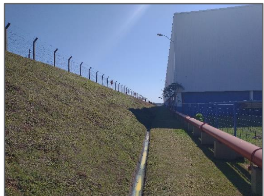
Lateral do imóvel
