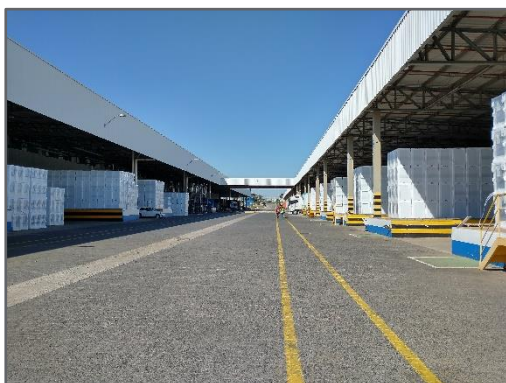
Pátio de manobras e galpões
