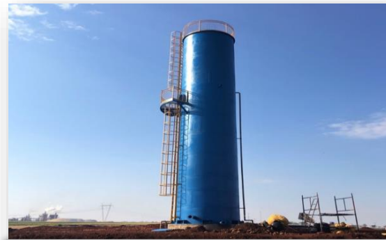
Caixa D'água finalizada
