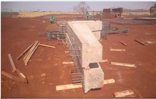
Fabricação de pré moldados in loco
