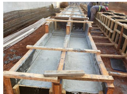
ARMAÇÃO DE BALDRAME
