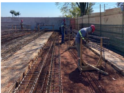
ARMAÇÃO DAS ESTACAS
