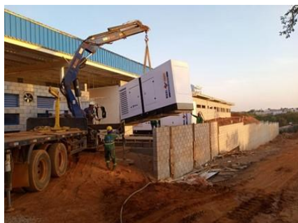
INSTALAÇÃO GERADORES
