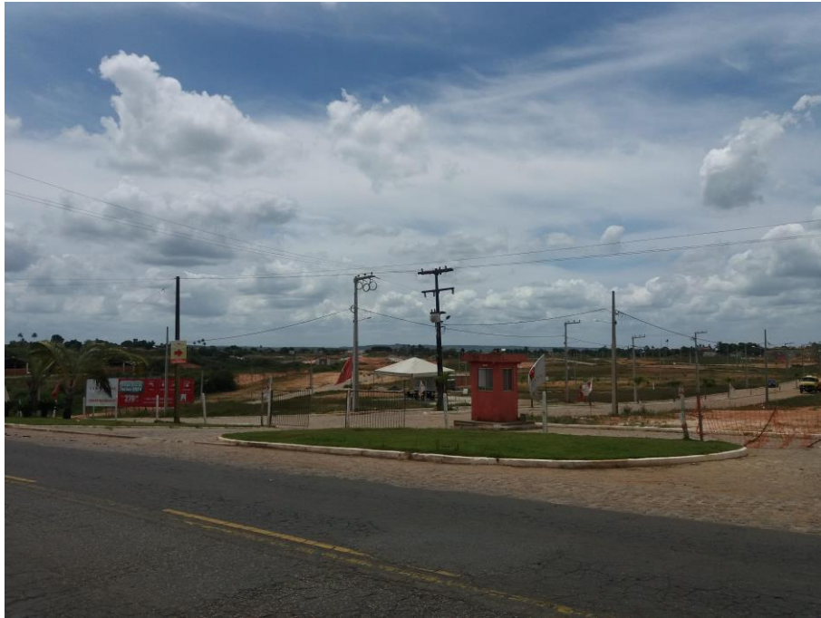
Guarita de acesso ao empreendimento
