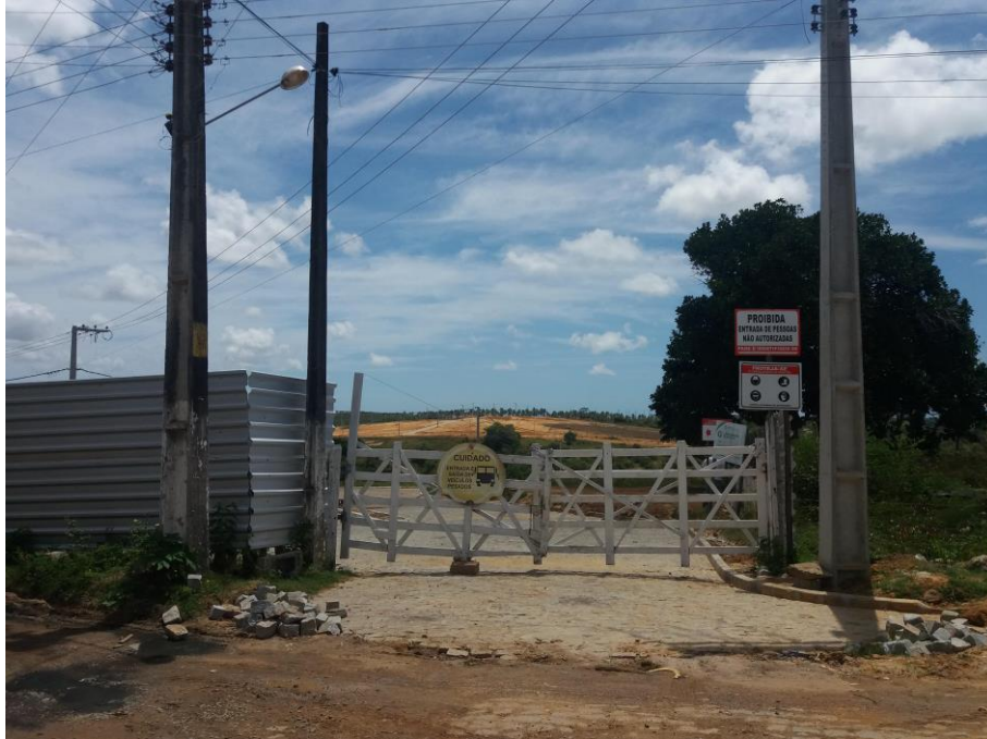
Entrada do empreendimento (em construção)
