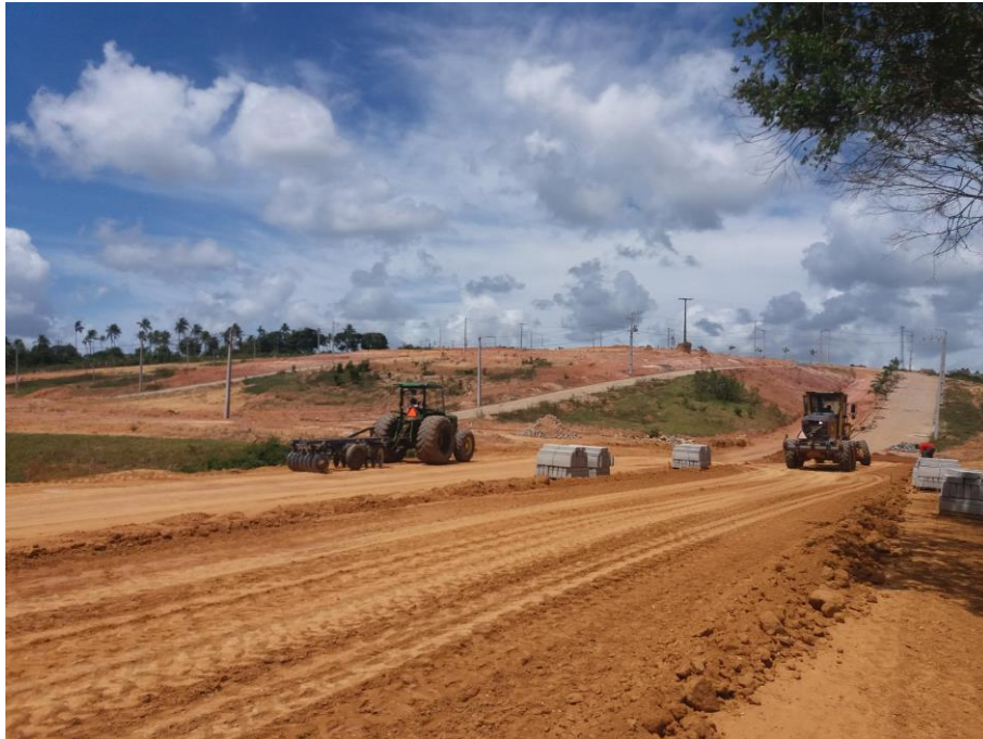
Empreendimento em construção
