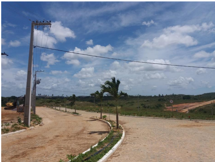
Empreendimento em construção
