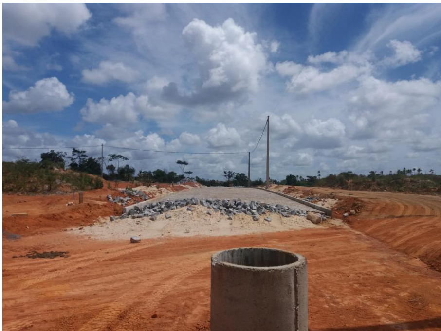
Empreendimento em construção
