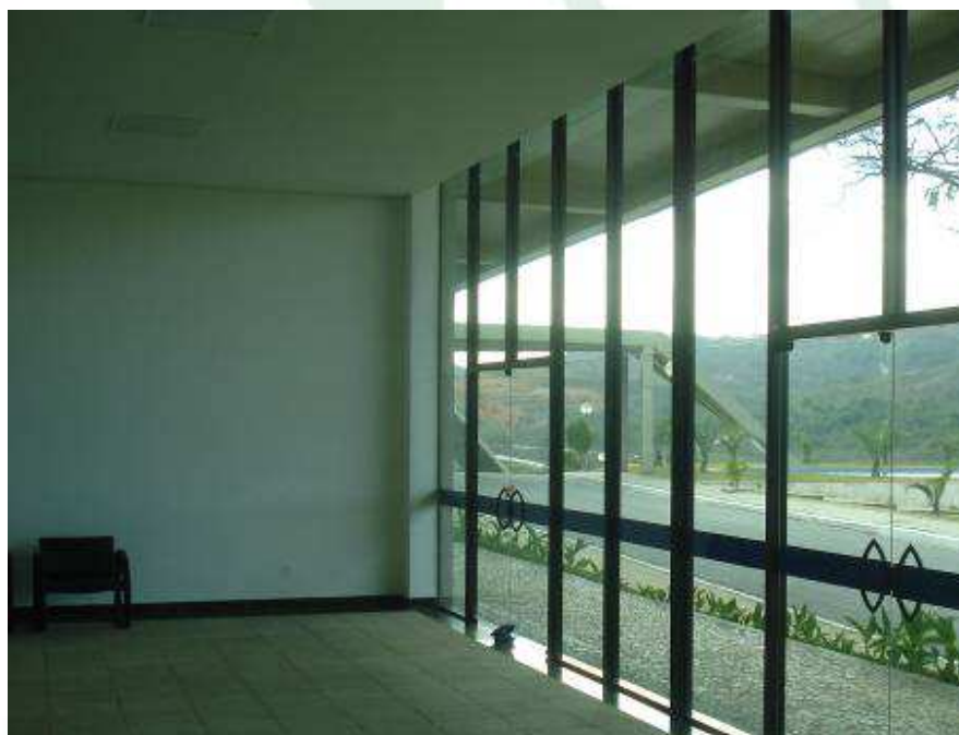
Foto 21: Vista interna do Velório 01
