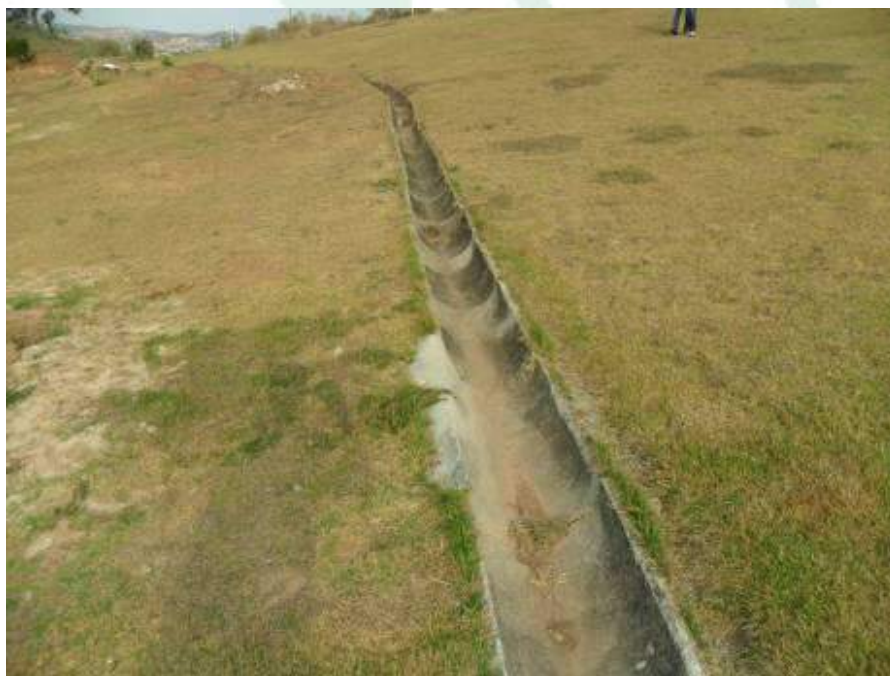
Foto 11: Detalhe da área de escoamento pluvial
