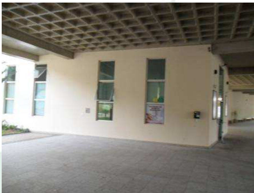
Foto 17: Hall de entrada para os Velórios
