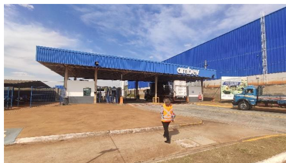
Fachada da portaria do Centro de Distribuição
