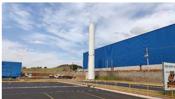
Reservatório de água do centro de distribuição
