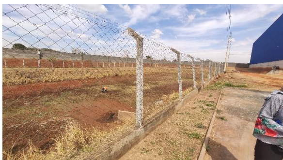
Reservatório de retenção de águas pluviais
