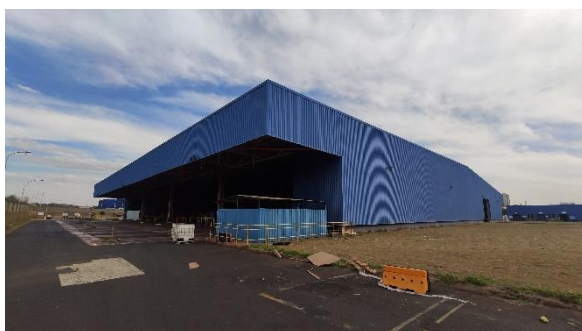
Fundos do galpão do centro de distribuição
