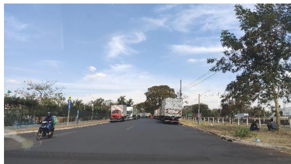
Rua marginal à Rodovia Anhanguera (imóvel à direita)
