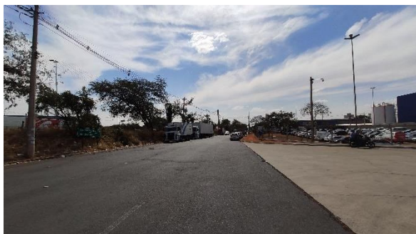
Rua marginal à Rodovia Anhanguera (imóvel à esquerda)
