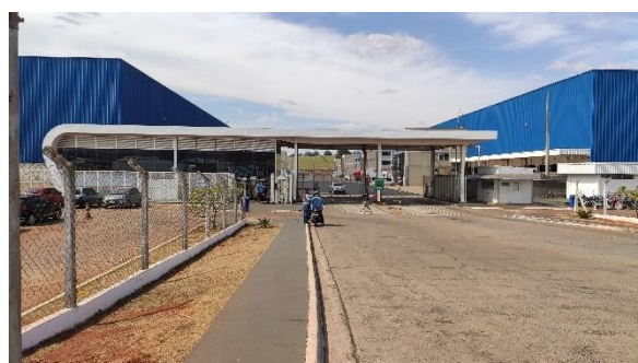
Portaria de acesso ao condomínio logístico
