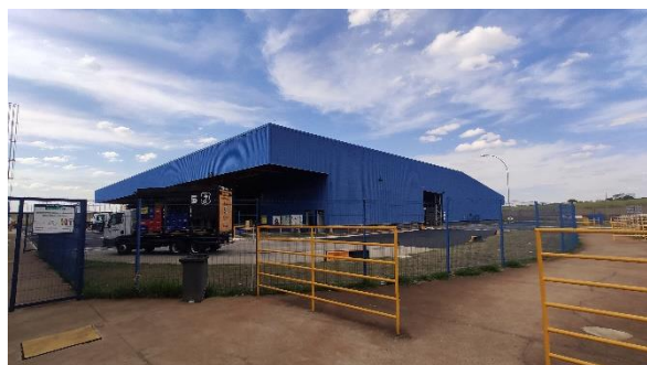
Fachada do galpão do centro de distribuição
