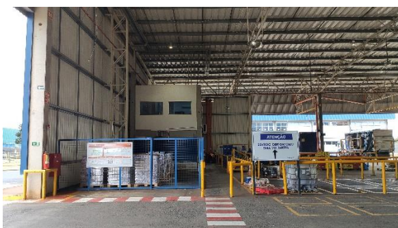
Vista para área de apoio do centro de distribuição
