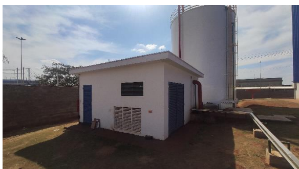
Reservatório e casa de bombas
