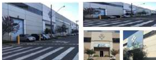
CEA Atibaia / Jarinú, SP Av. Tégula, 888, Ponte Alta Área Construída: 28.797 m 2 Participação: 100% Pé-direito (m): 8,5-8,8 Capacidade do Piso (ton/m 2 ): 5
