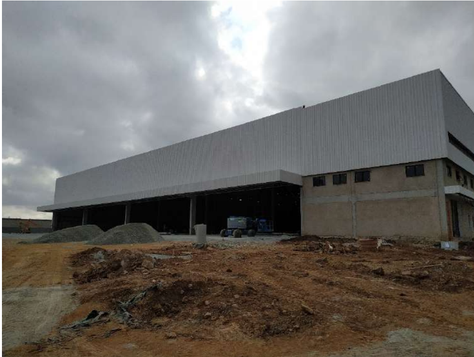
FACHADA PRINCIPAL DO GALPÃO
