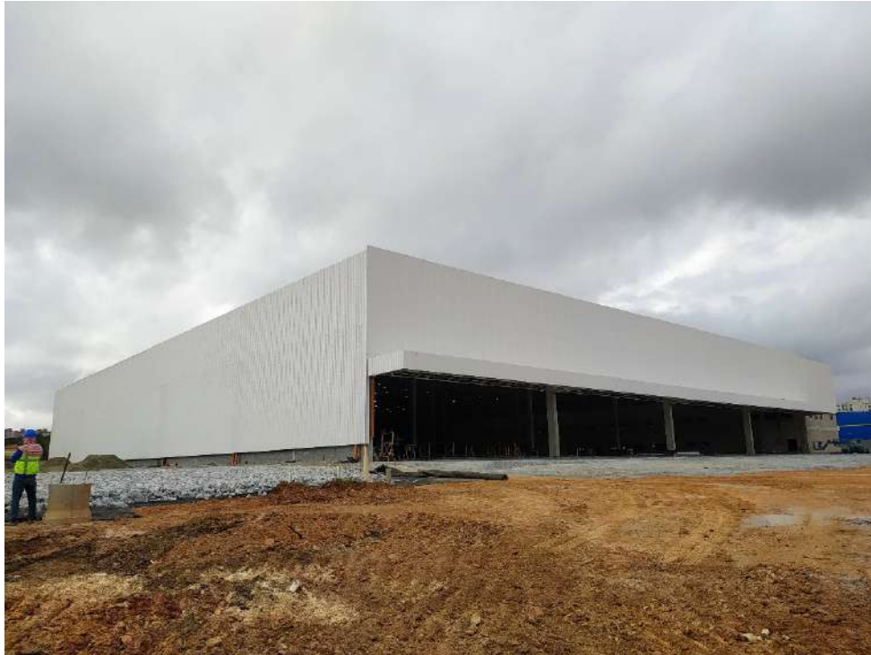
VISTA DO GALPÃO PRINCIPAL
