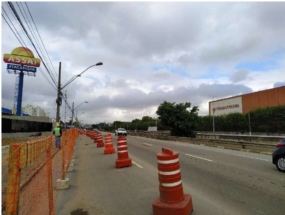
VISTA PARA AVENIDA DOS ESTADOS – SENTIDO SUL
