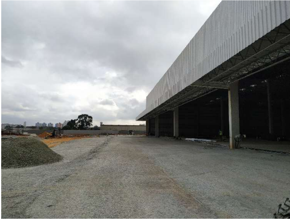
VISTA ENTRADA PRINCIPAL DO GALPÃO
