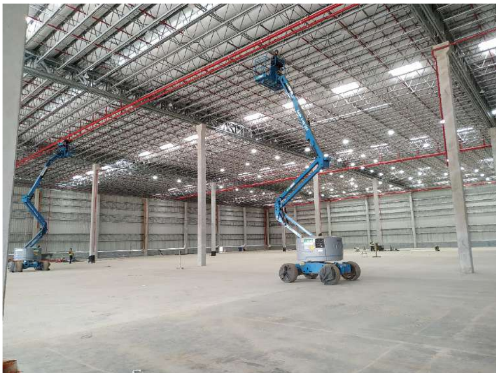
VISTA INTERIOR DO GALPÃO
