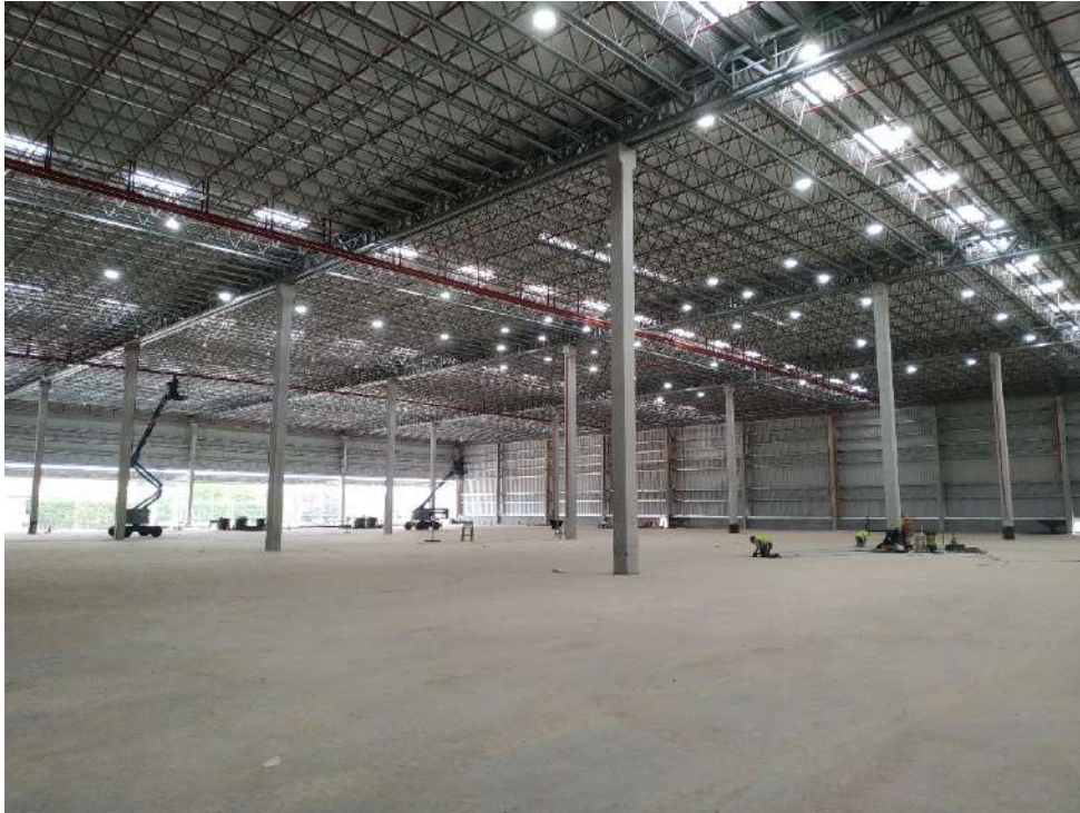
VISTA INTERIOR DO GALPÃO
