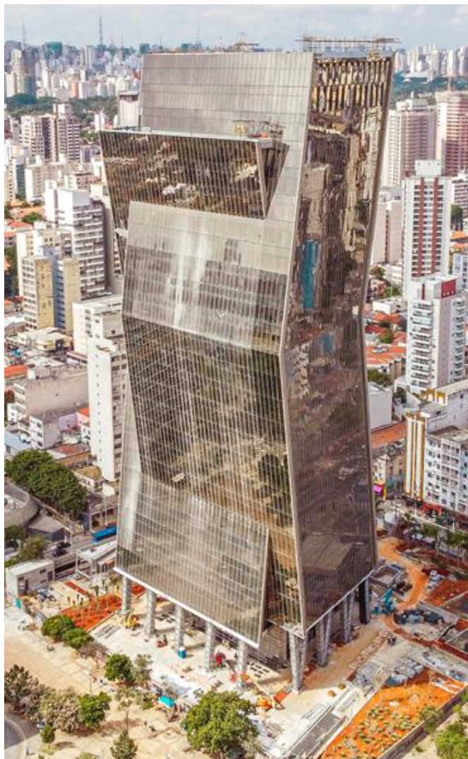
Foto da obra em andamento
