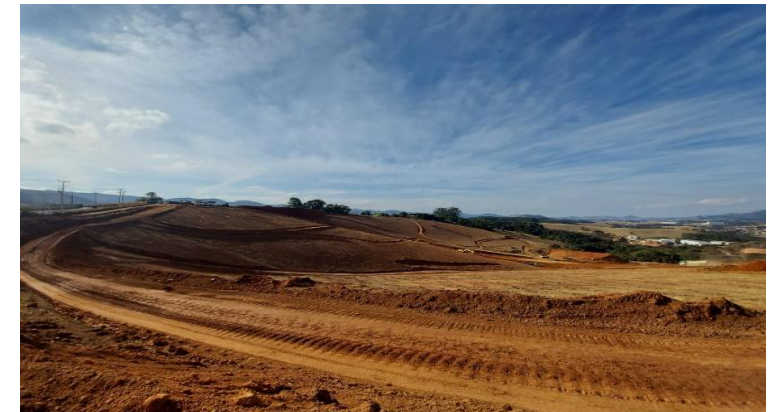
Foto da obra em andamento
