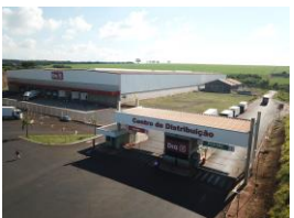
CD Dia% Ribeirão Ribeirão Preto, SP Via José Luiz Galvão, 1.905 Área construída: 21.136 m 2 Participação: 100% Pé-direito (m): 12 Capacidade do Piso (ton/m 2 ): 6
