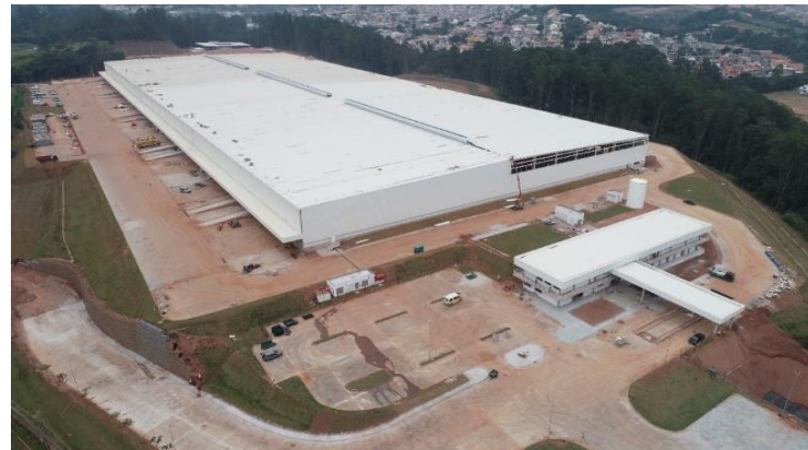
Foto da obra em andamento
