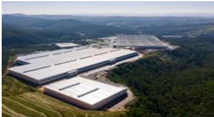
Foto da obra em andamento
