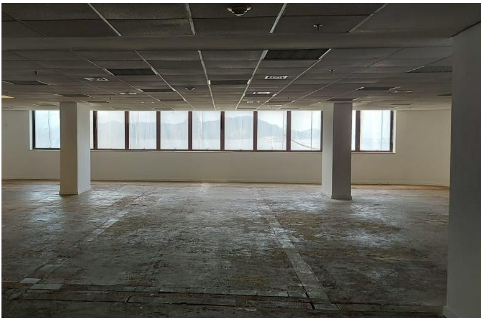
Vista interna de conjunto tipo vago
