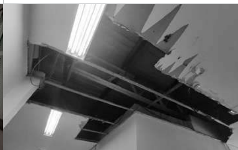
Corredor de entrada de funcionários
