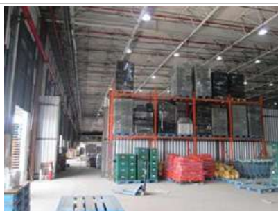
Detalhes do galpão
