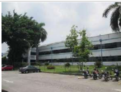
Vista frontal – Prédio administrativo
