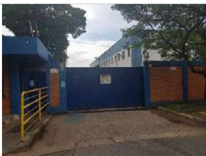
Acesso ao Galpão
