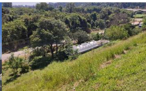
Talude e ETE
