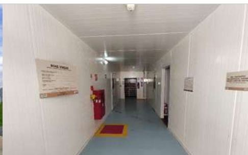
Salão Industrial 2º andar – Corredor de acesso
