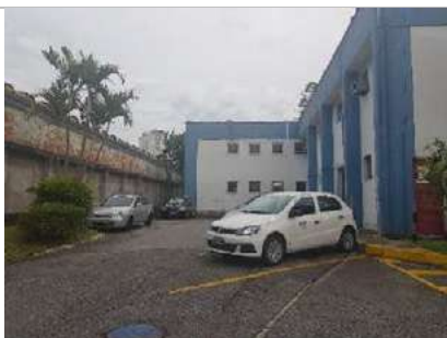
Fachada Lateral Prédio Administrativo (desativado)
