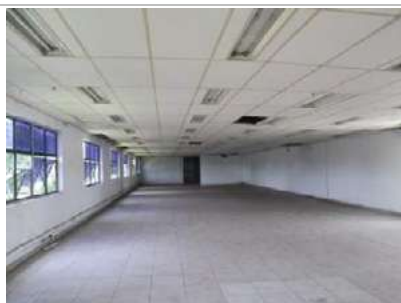
Detalhes internos do Administrativo
