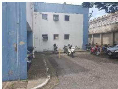
Fachada Lateral Prédio Administrativo (desativado)
