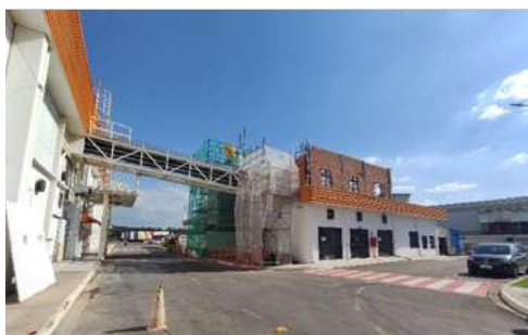
Vista de bloco em reformas de expansão
