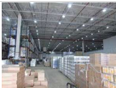
Detalhes do galpão
