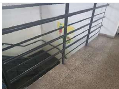
Escada de Acesso Pav. Superior – Prédio Administração
