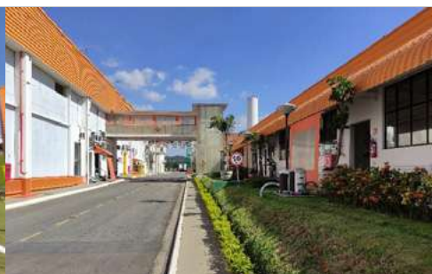
Vista externa entre Salão Industrial e bloco de vestiário
