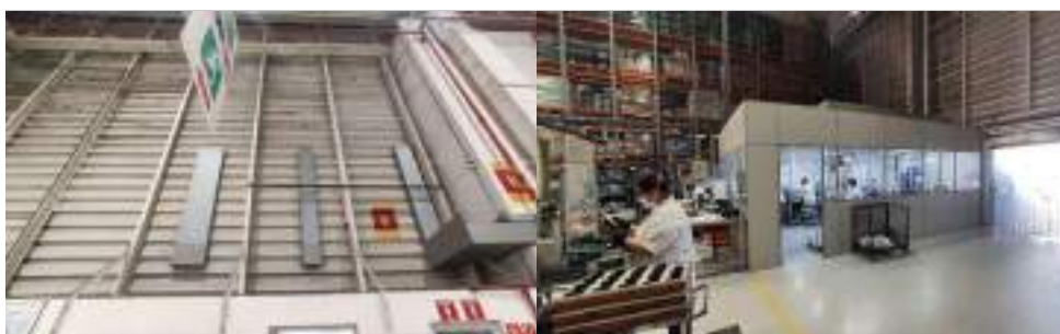
Vista do fechamento metálico
