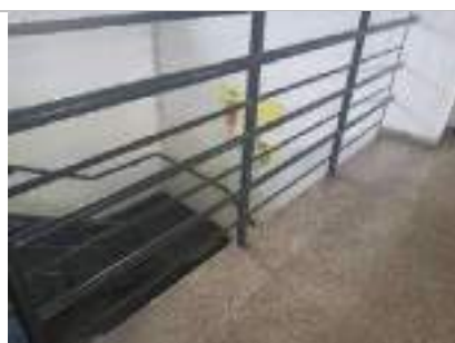
Escada de Acesso Pav. Superior – Prédio Administração
