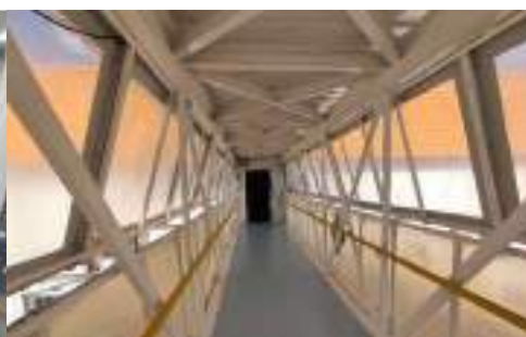
Passarela de acesso
