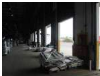
Detalhes do galpão - docas
