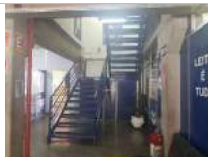
Escada de Acesso ao pav. Superior
