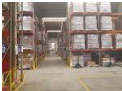
Visão Geral Galpão
