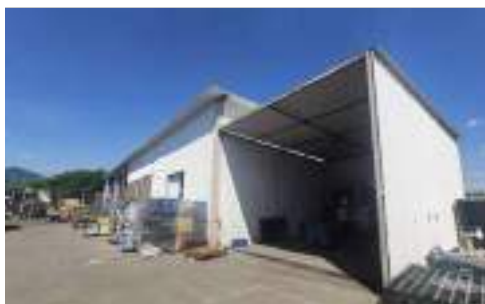
Galpão de reciclagem e resíduos contaminantes
