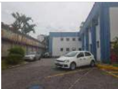
Fachada Lateral Prédio Administrativo (desativado)
