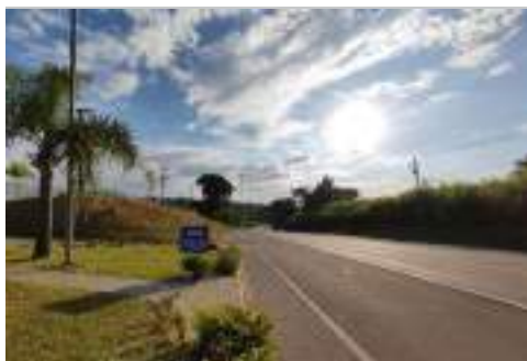
Rod. Miguel Melhado Campos, vista à esquerda
