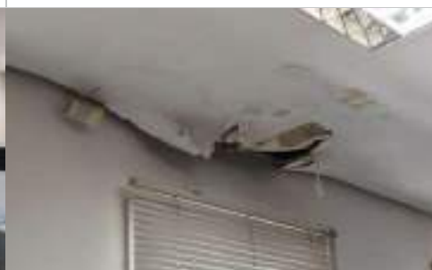
Sala Principal – Admin. – 2º Andar
