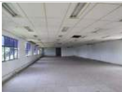
Detalhes internos do Administrativo
