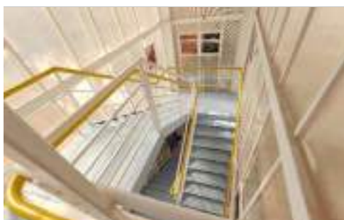
Escada da passarela de acesso
