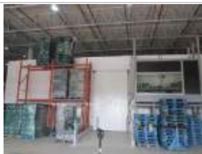
Galpão – Centro Frio novo
