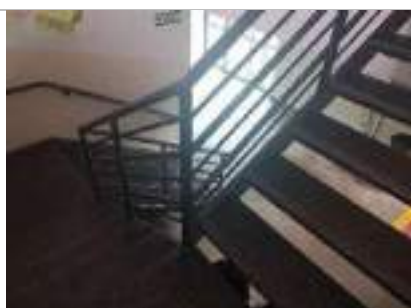
Escada de Acesso Pav. Superior – Prédio Administração
