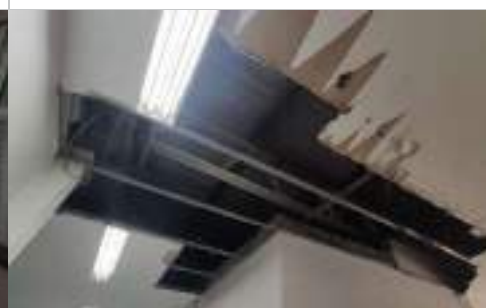
Corredor de entrada de funcionários
