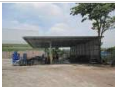
Cobertura de lavagem
