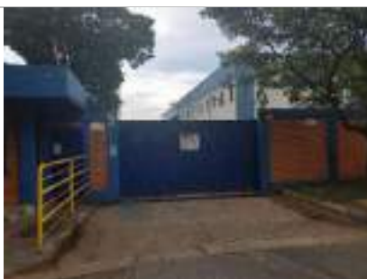
Acesso ao Galpão
