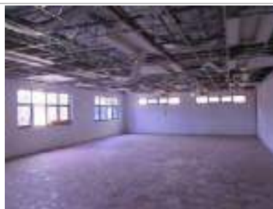
Detalhes internos do Administrativo
