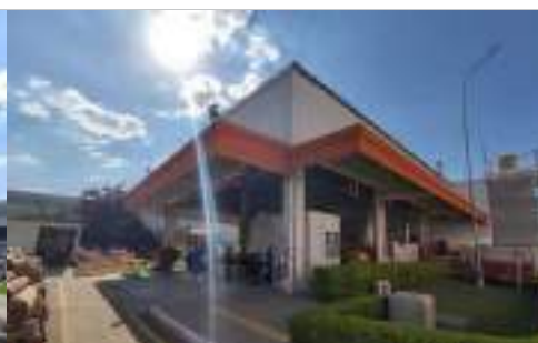
Vista do galpão de armazenamento
