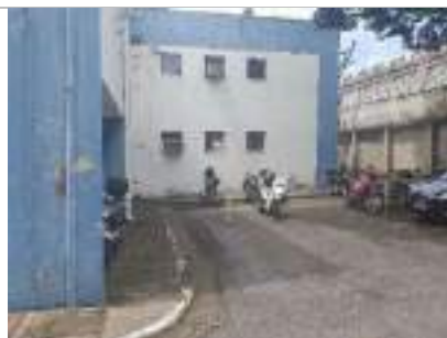
Fachada Lateral Prédio Administrativo (desativado)
