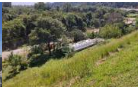
Talude e ETE
