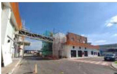
Vista de bloco em reformas de expansão
