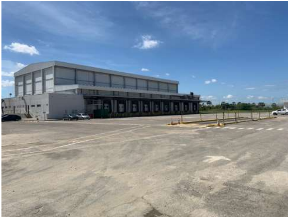
Vista geral externa do imóvel
