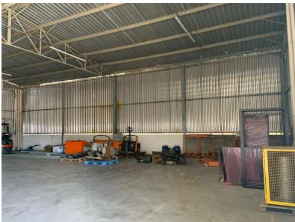
Vista geral interna do imóvel
