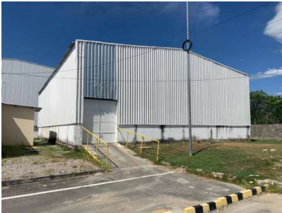
Vista geral externa do imóvel
