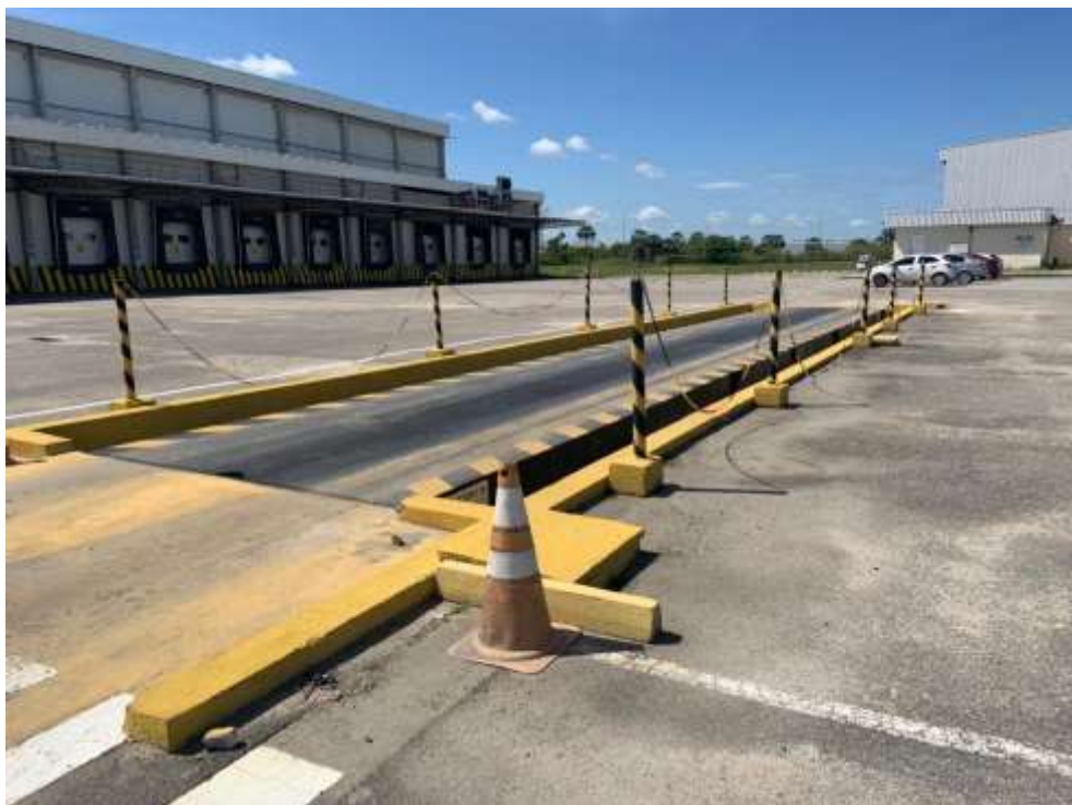
Vista geral externa do imóvel
