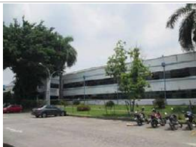
Vista frontal – Prédio administrativo
