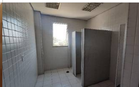
Sanitário – Admin – 2º Andar
