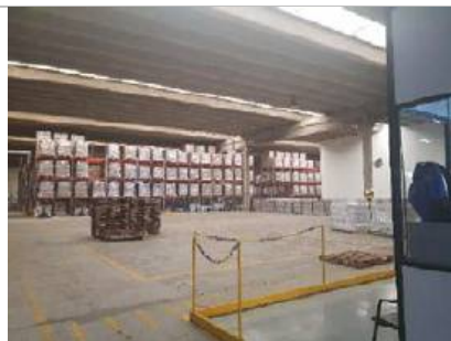
Visão Geral Galpão
