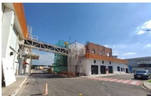
Vista de bloco em reformas de expansão
