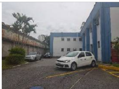
Fachada Lateral Prédio Administrativo (desativado)
