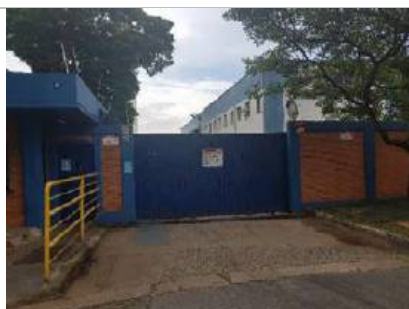
Acesso ao Galpão
