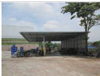
Cobertura de lavagem
