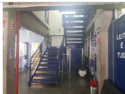
Escada de Acesso ao pav. Superior
