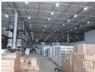
Detalhes do galpão
