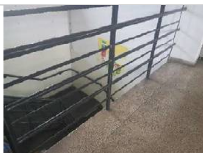
Escada de Acesso Pav. Superior – Prédio Administração
