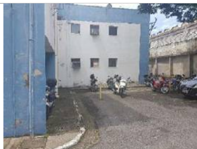
Fachada Lateral Prédio Administrativo (desativado)
