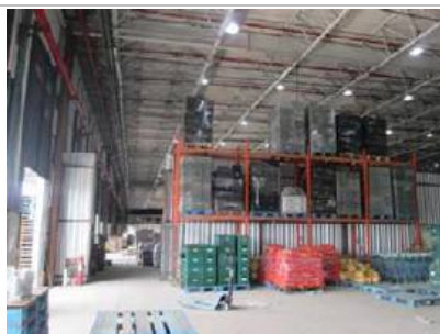
Detalhes do galpão
