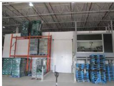
Galpão – Centro Frio novo
