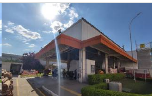
Vista do galpão de armazenamento
