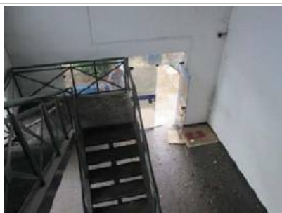
Detalhes internos do Administrativo
