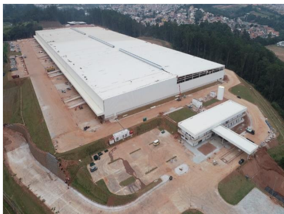
Execução de obras – Foto Panorâmica
