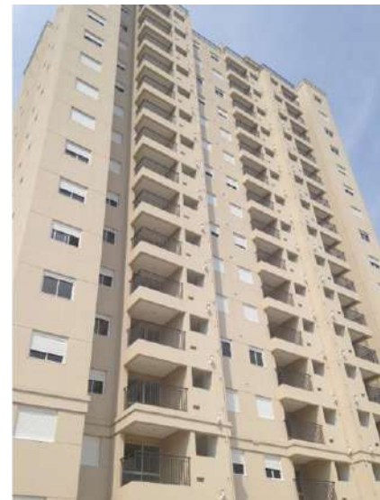
Foto do Empreendimento
