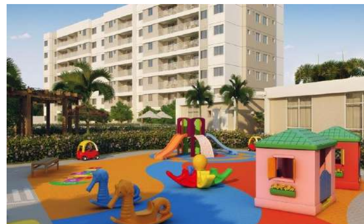
Foto do Empreendimento
