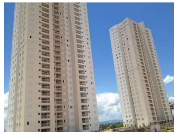
Foto do Empreendimento
