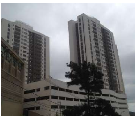
Foto do Empreendimento
