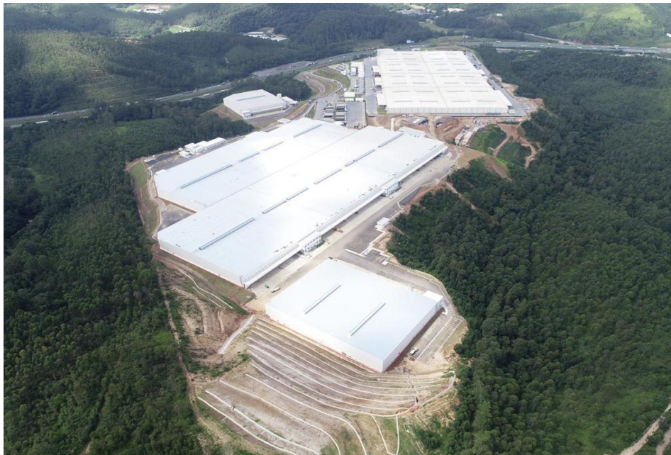
Foto da obra em andamento
