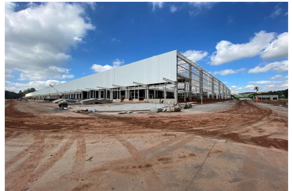
Foto da obra em andamento
