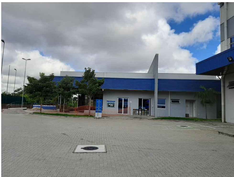
Vista externa do imóvel
