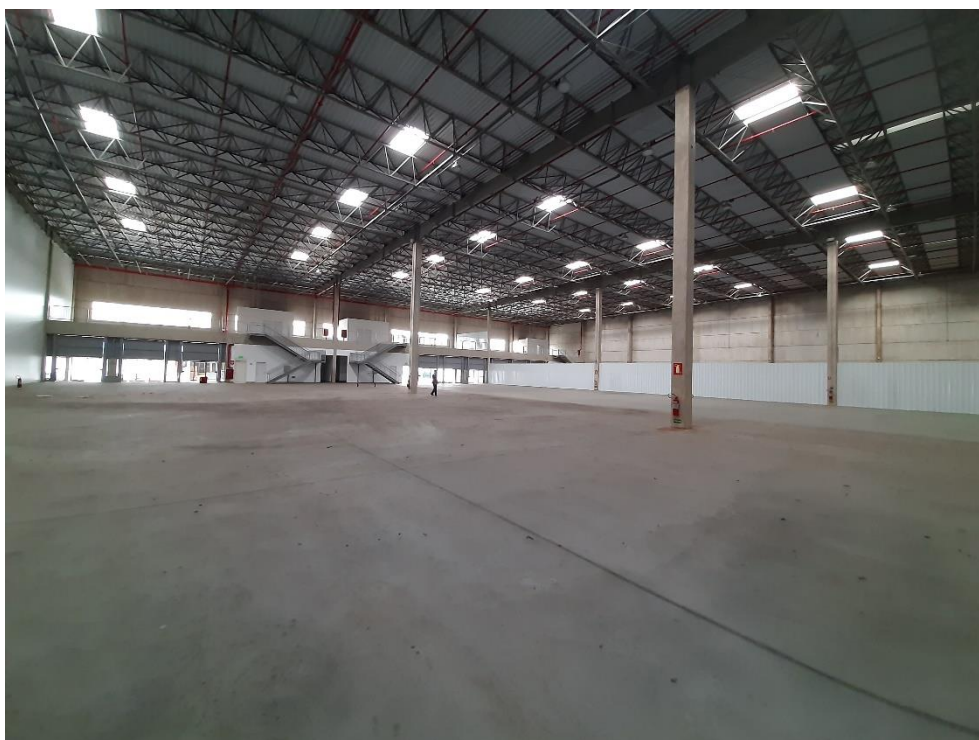
Vista interna de um dos módulos do imóvel
