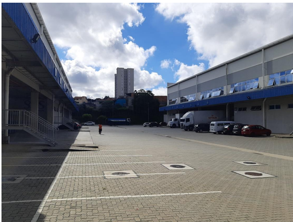
Vista externa do imóvel
