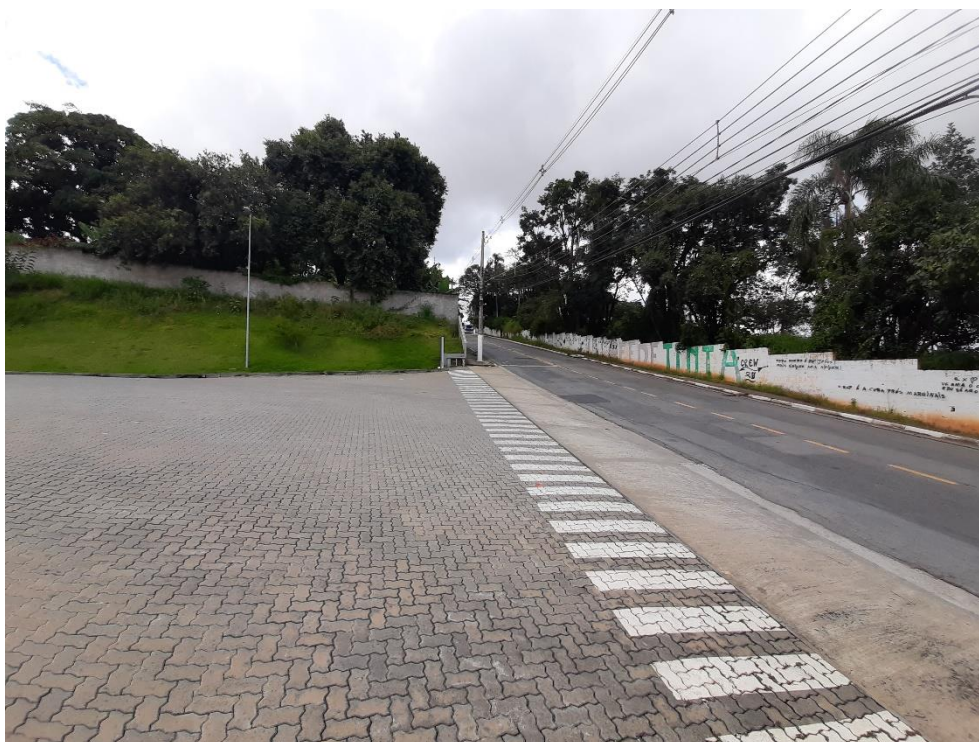
Vista da Via de Acesso ao Imóvel
