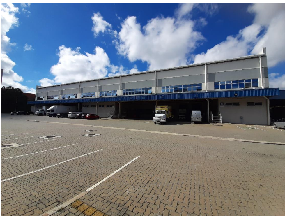
Vista externa do imóvel
