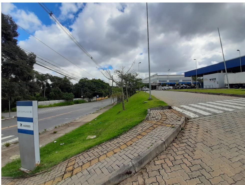
Vista da Via de Acesso ao Imóvel
