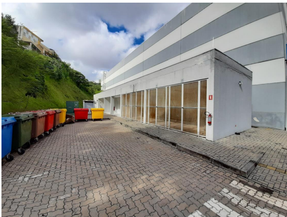
Vista da área de apoio do imóvel
