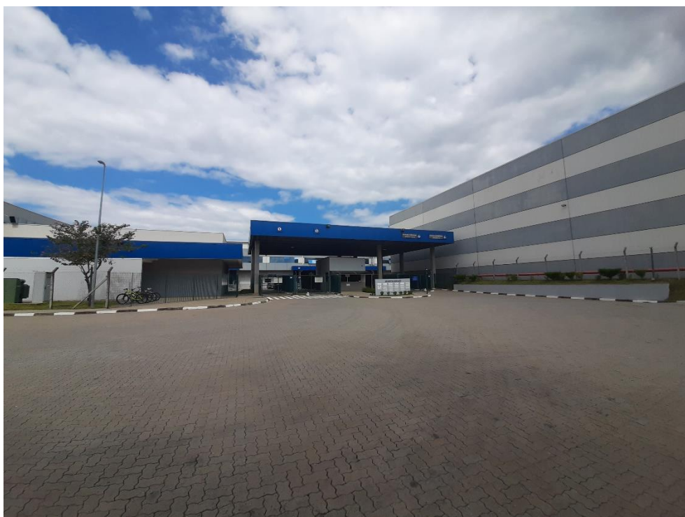
Portaria de acesso ao imóvel
