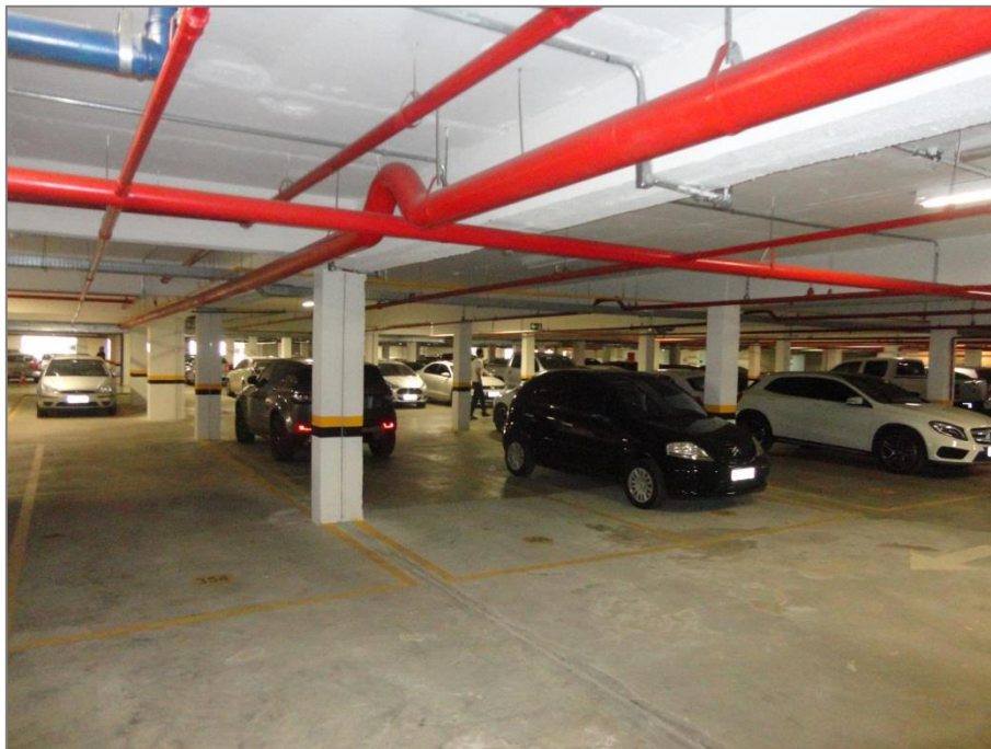
Estacionamento no subsolo 1
