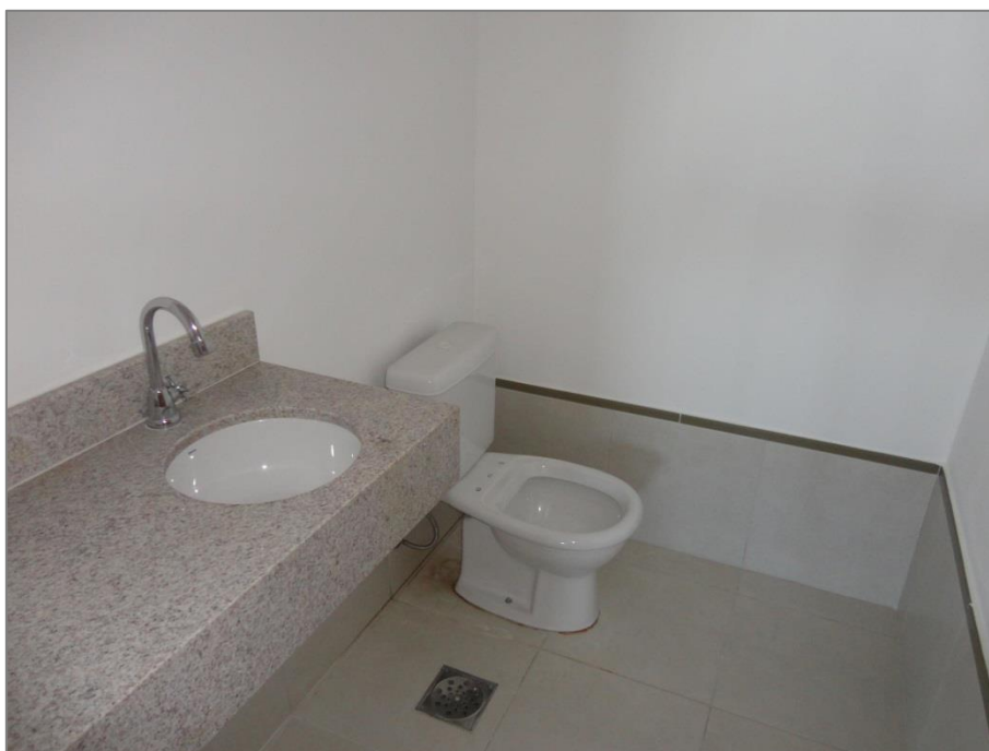
Tipologia dos banheiros das salas corporativas
