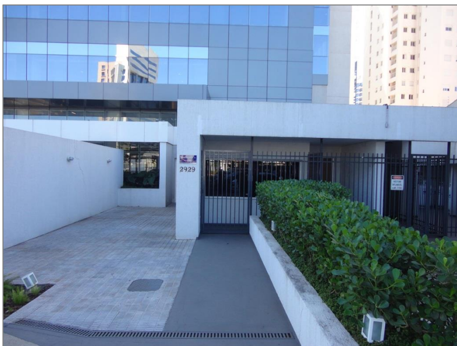
Entrada de serviço da Torre B
