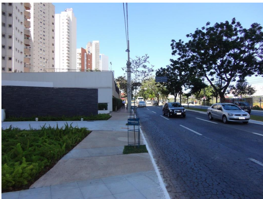
Avenida Deputado Jamel Cecílio, com o imóvel à esquerda
