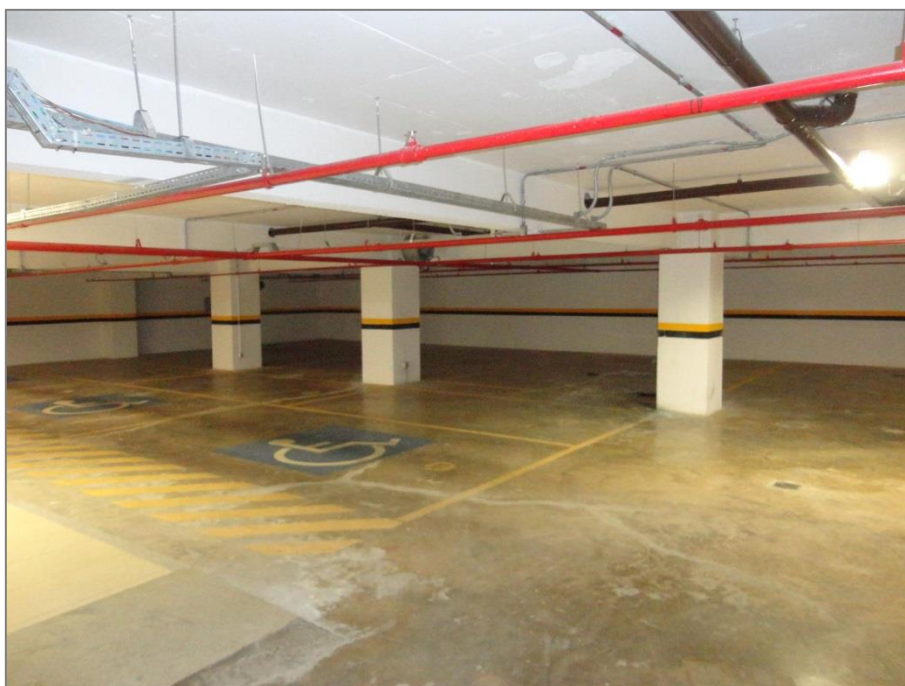
Estacionamento no subsolo 2
