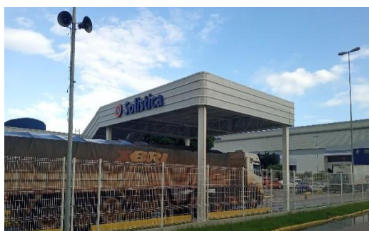
1. Pórtico da portaria
