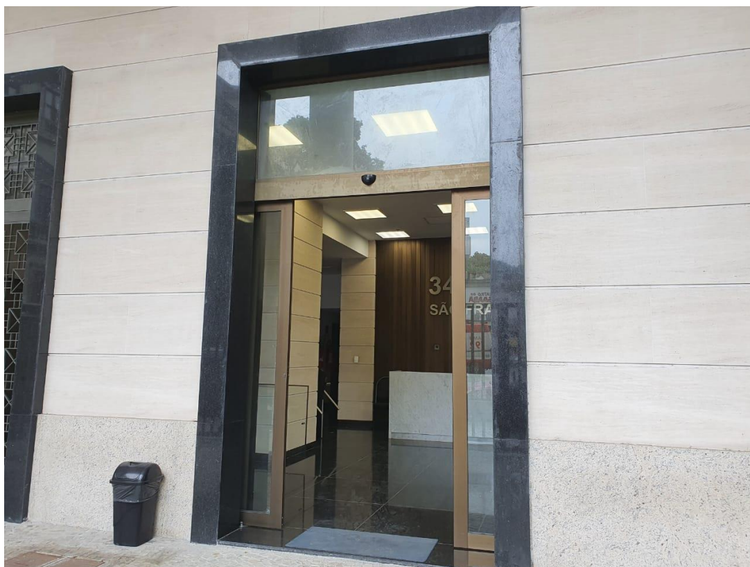
ENTRADA DO EDIFÍCIO
