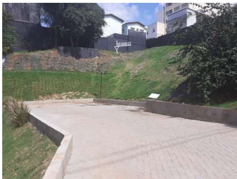
Vista interna do imóvel
